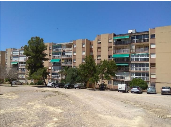
Detall d'esplanada sense asfaltar
