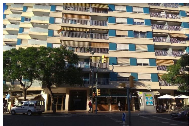
Detall edificació Nou Eixample Nord, antiga
