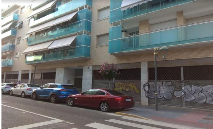
Detall de baixos abandonats i en mal estat. Carrer Reial
