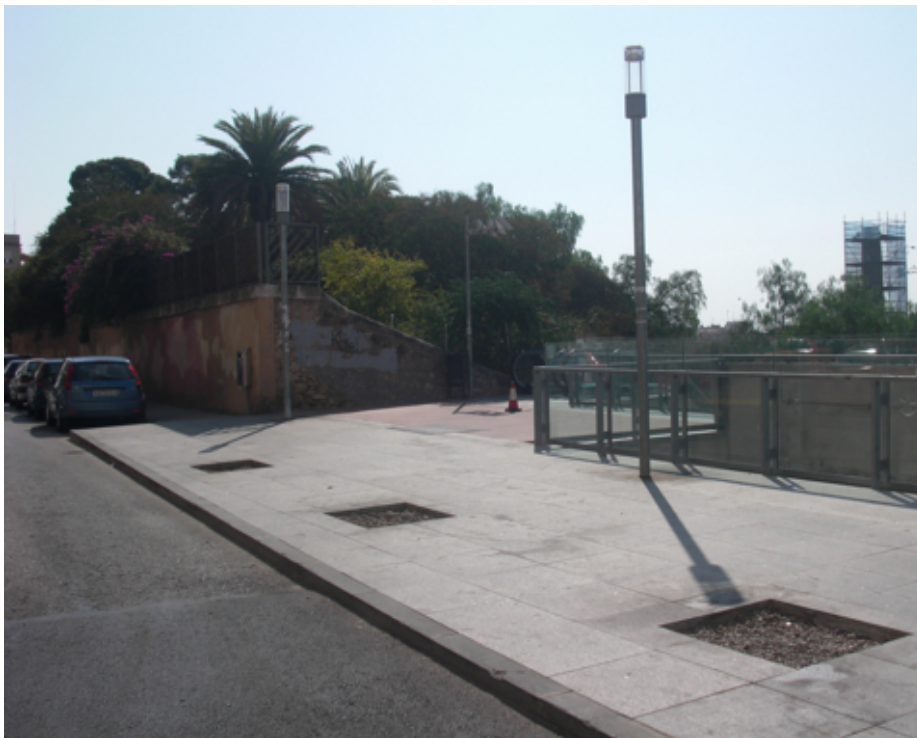
Part davantera de l'edifici, amb escales que salven el desnivell entre carrers existents al cantó sud-oest
