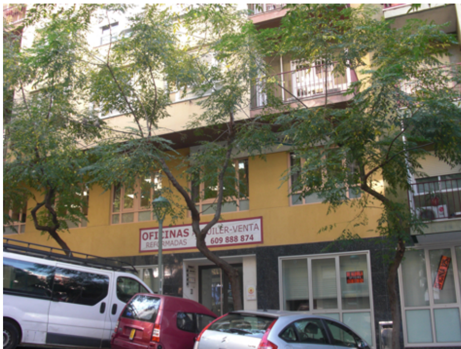
Façana nord de l'edifici
