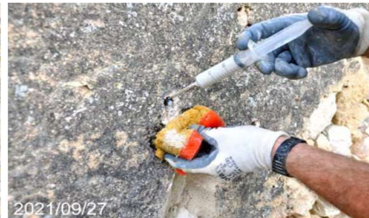
Fig. 20. Utilització del pernat (combinat amb hisellats perimetrals) utilitzat per a fixació de gran placa de morter al Fortí Negre
