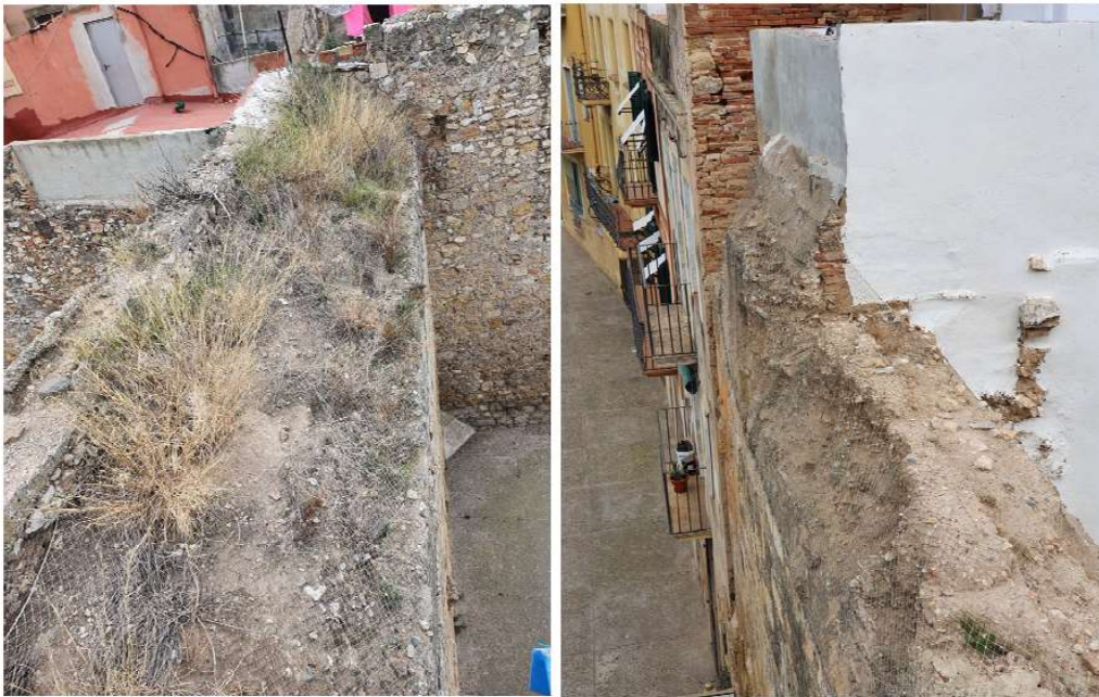
Fig. 25. Estat previ i posterior a la neteja de vegetació en els coronaments de tàpia medievals del tram 1 del sector 8 (Via Imperi)
