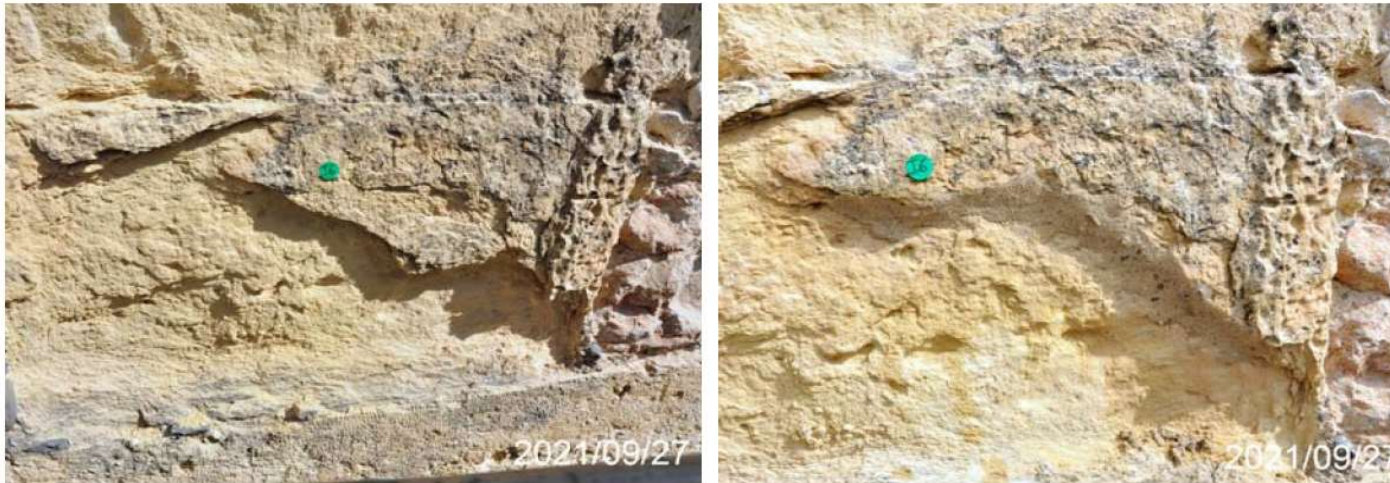
Fig. 16. Exemple de bisellat utilitzat per a la fixació de desplaçament superficial en pedra sorrenca tipus Llorito
