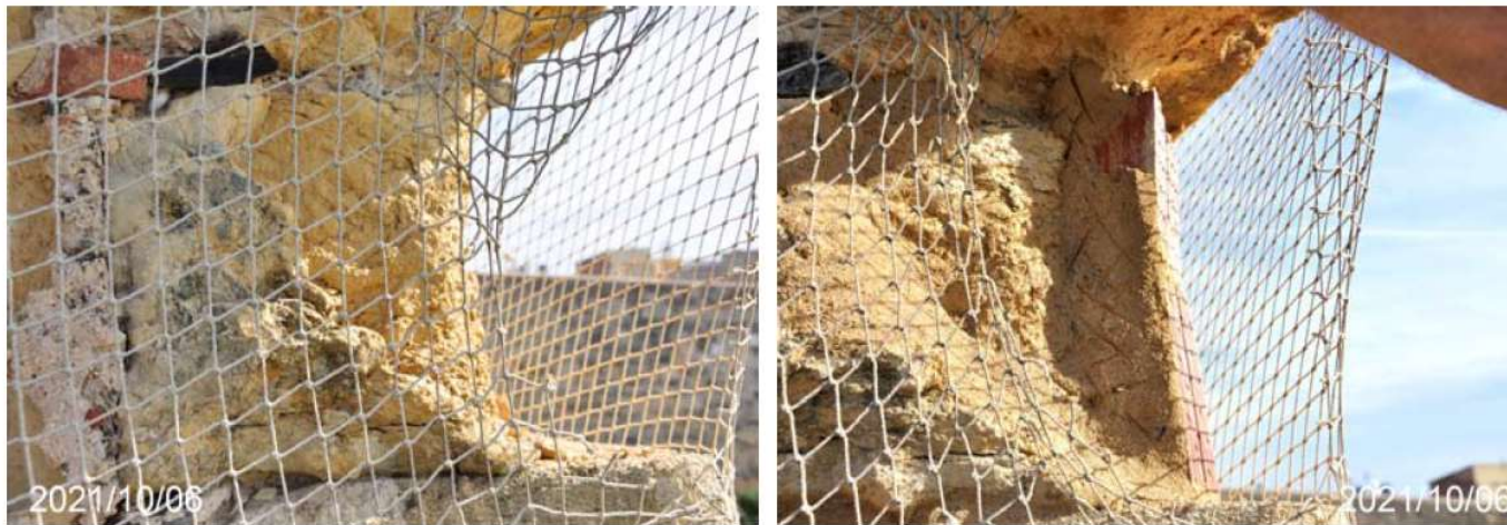
Fig. 27. Petita restitució volumètrica provisional en cantonada del Fortí Negre feta per garantir estabilitat cordó superior de pedra
