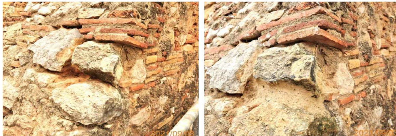
Fig. 22. Exemple de reposició de morter de junts en una àmplia zona del parament interior de la muralla a la zona de Baixada del Roser a tocar del contrafort
