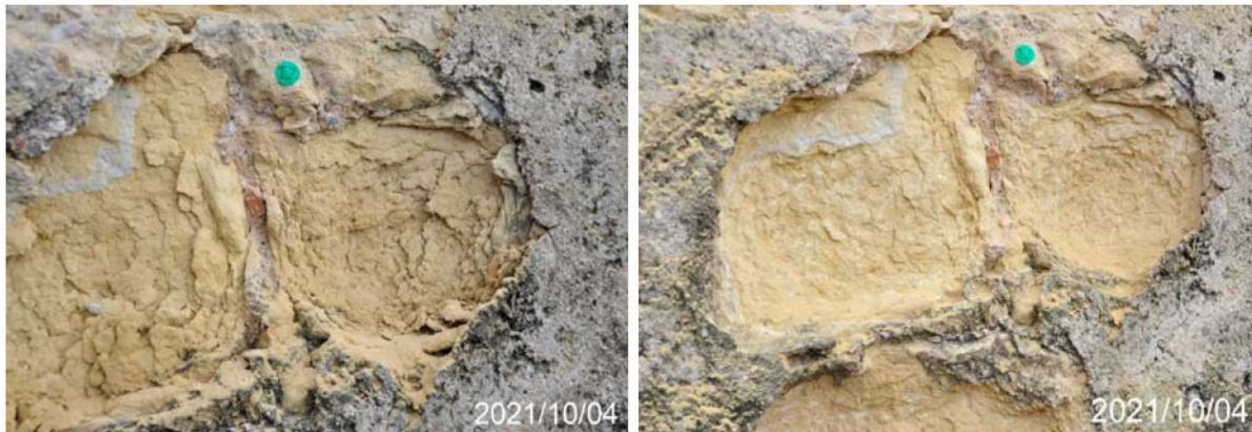
Fig. 13. Exemple d'estat previ i posterior a l'aplicació sobre pedra de la mesura de sanejat superficial i retirada de petits fragments
