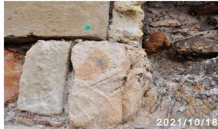
Fig. 19. Fixació de fragment de fragment de pedra amb desplaçat important mitjançant pernat (estat previ i final).
