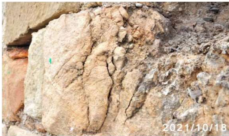
Fig. 19. Fixació de fragment de fragment de pedra amb desplaçat important mitjançant pernat (estat previ i final).
