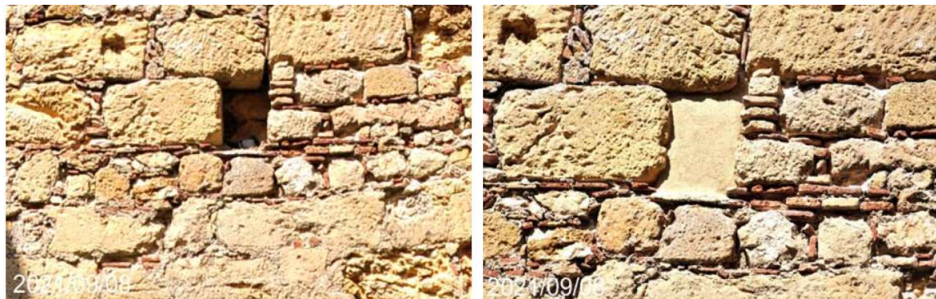
Fig. 26. Exemple d'estat previ i posterior a cegat de forat en el tram 14 del sector 7 (zona de Baixada del Roser)
