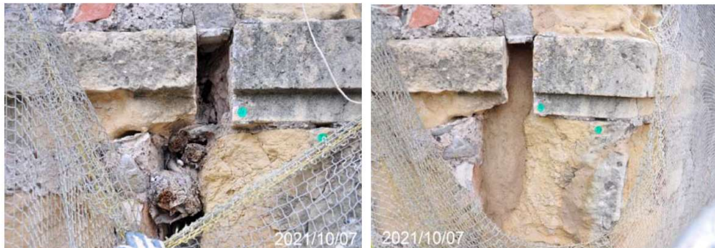
Fig. 15. Estat previ i final del segellat de la gran esquerda existent al Fortí Negre, amb eliminació prèvia d'arrel interior
