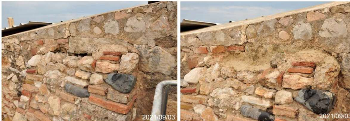
Fig. 14. Exemple d'estat previ i final del segellat d'una gran esquerda a través de la que es produïen filtracions importants d'aigua
