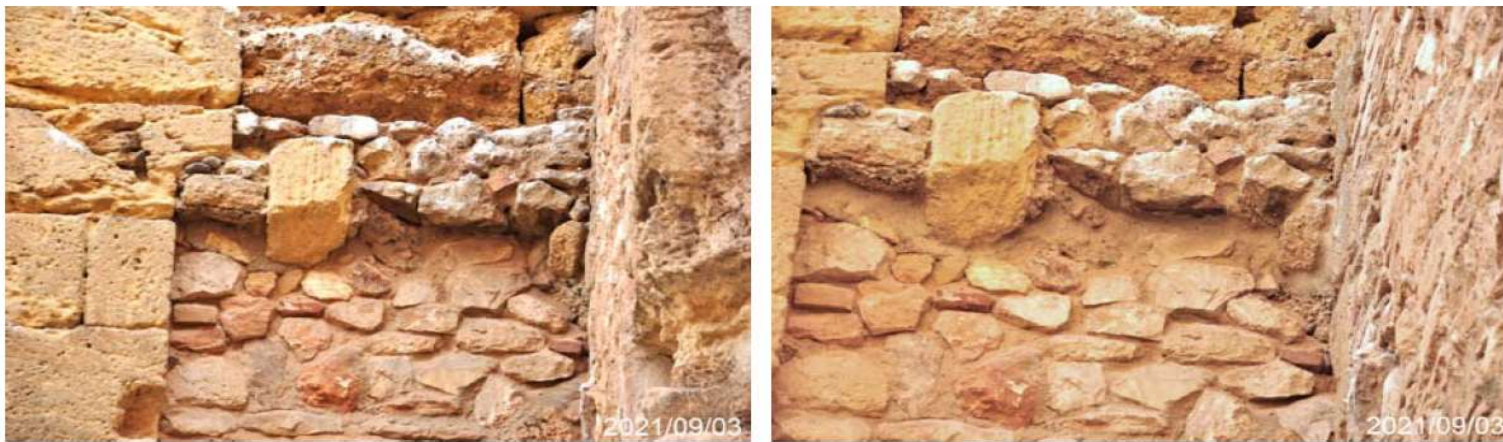
Fig. 22. Exemple de reposició de morter de junts en una àmplia zona del parament interior de la muralla a la zona de Baixada del Roser a tocar del contrafort
