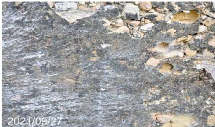
Fig. 20. Utilització del pernat (combinat amb hisellats perimetrals) utilitzat per a fixació de gran placa de morter al Fortí Negre
