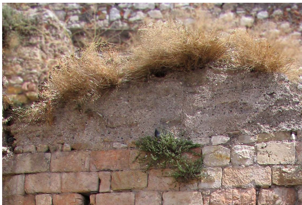
A1 18 – Detall de parapet de tàpia arrebossada al coronament del pany del sector 8 – Via de l'imperi Romà.
