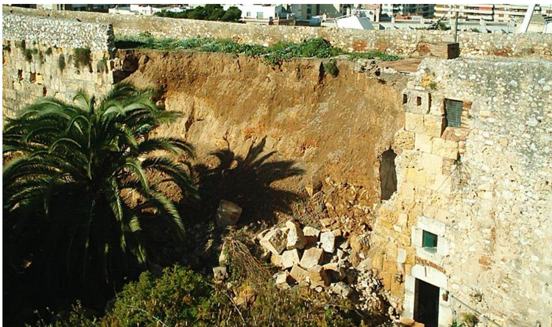
Vista de l'ensulsiada al tram de l'hort del Palau de l'Arquebisbe (2005)
