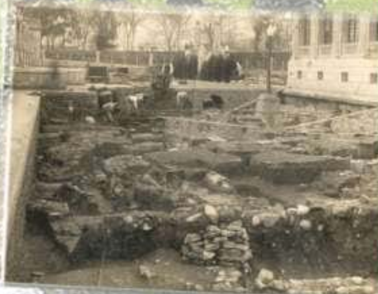
Els treballs d'excavació es van dur a terme durant deu anys, des de 1923 fins a 1933, dirigits per l'arqueòleg mossèn Joan Serra Vilaró, posant en descobert més de 2.000 tombes (1933/03/00)
