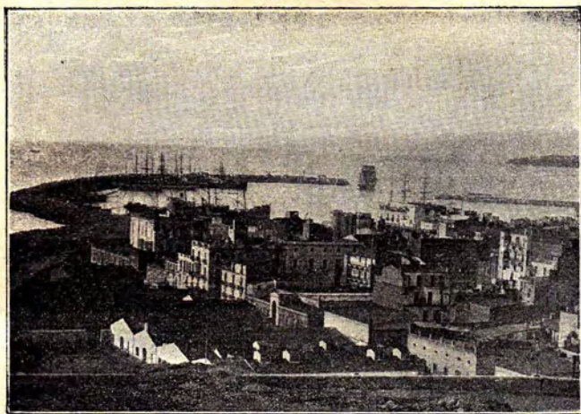
Vista del Muelle
