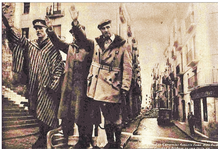
Els generals franquistes Asensio, Juan Bautista Sánchez i Solchaga, a la plaça de les Cols de TGN. FOTO: CEDIDA PEL CENTRE D'IMATGES DE TARRAGONA/L'ARXIU
