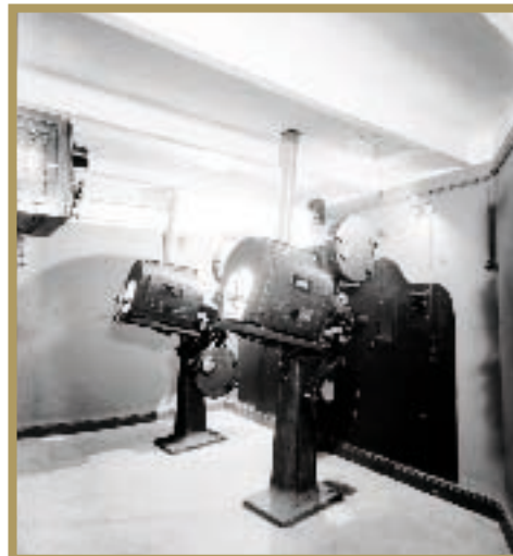
Cabina de projecció del Cinema Metropol. Fons Canadell. AHT
