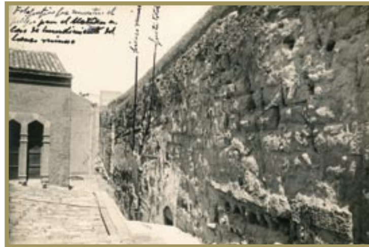
Informe de l'arquitecte municipal relatiu a l'estat de la muralla després d'un despreniment; concretament, un llenç immediat a la Torre del Cabiscol o Falsa Braga, 19 de febrer de 1932. Fotografia en la qual s'assenyalen part dels danys ocasionats. Foto: Chinchilla. AMT, Foment 2/32 i reg. 12449.
