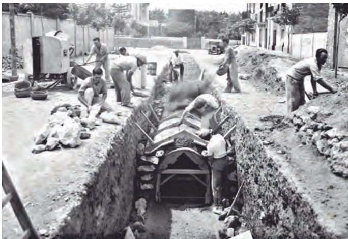
▲ Obriers treballant en el soterrament del clavoguera en els carrers de la ciutat, any 1934. Foto Vallvé. CIT / L'Arxiu
