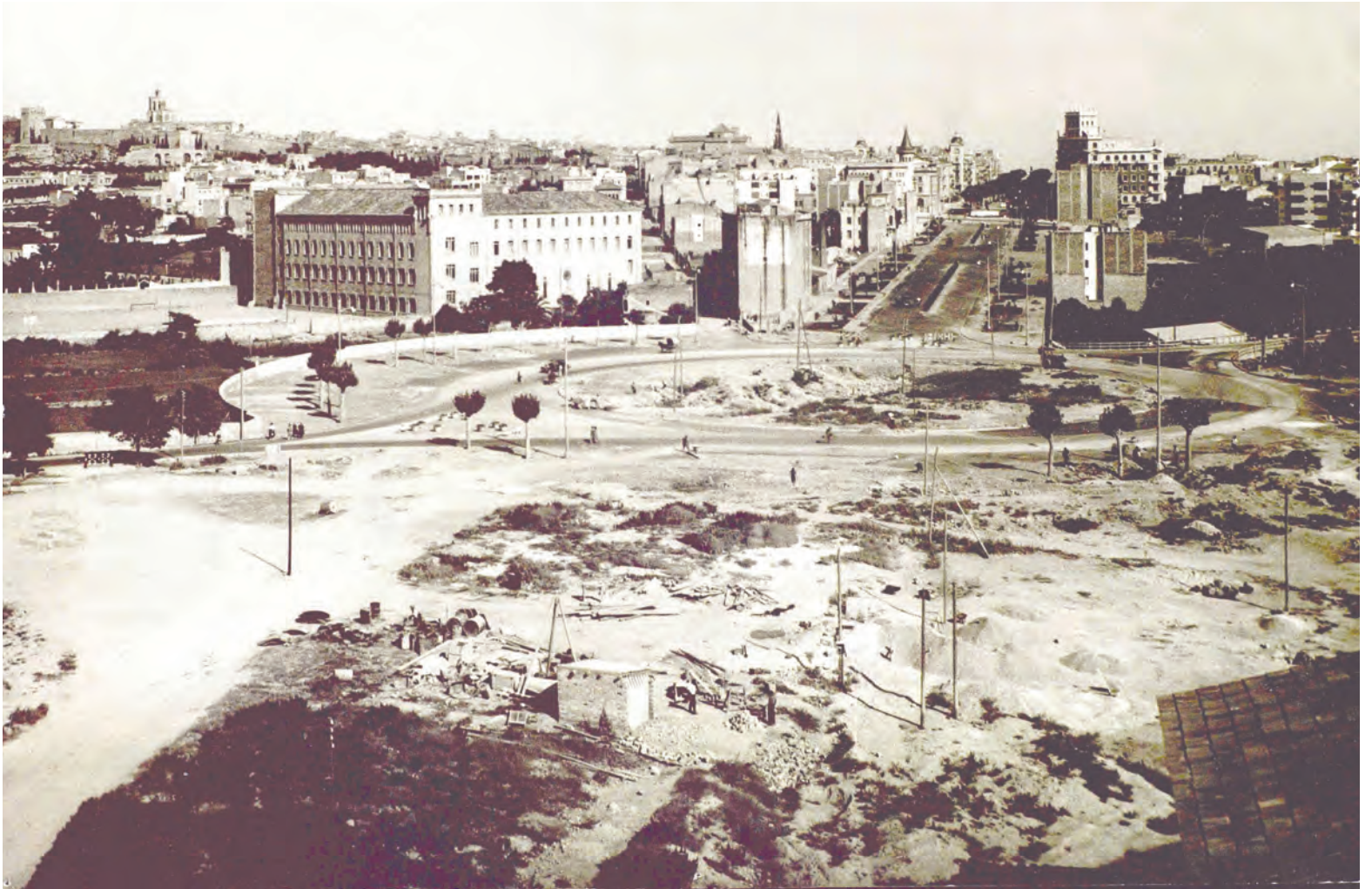
▲ Col·legi dels Germans dels Germans de les Escoles Cristianes de La Salle, durant les obres d'urbanització de la Plaça Imperial Tarraco, 1954. Foto Vallvé. CIT / L'Arxiu.
