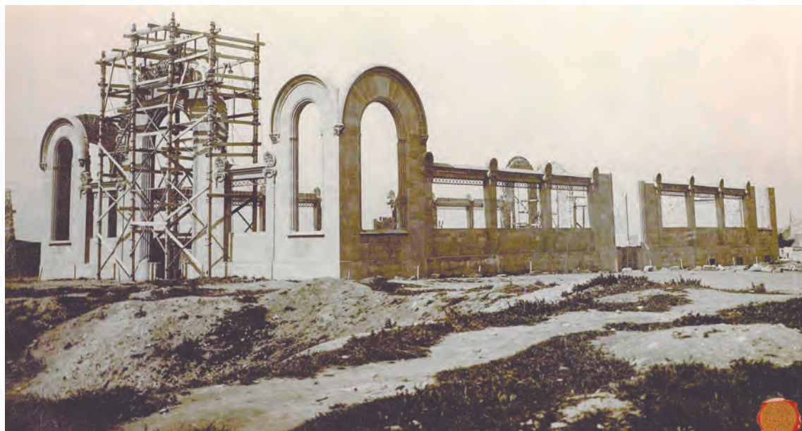
▶ Inici de la construcció de la façana principal i el perímetre exterior del Mercat Central, 1915. Foto Pallejà. CIT / L'Arxiu
