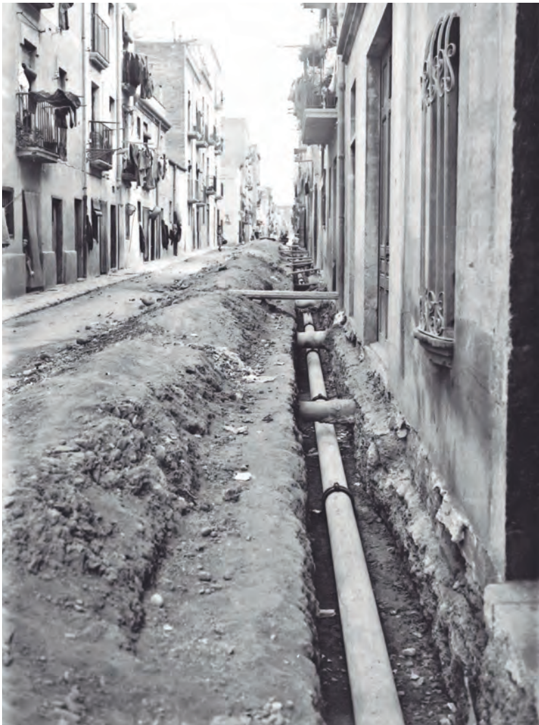
▲ Obres de soterrament de les canonades pels carrers de la ciutat, 1932. Foto Vallvé. CIT / L'Arxiu
