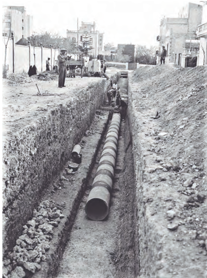
▲ Obres de soterrament de les canonades pels carrers de la ciutat, 1932. Foto Vallvé. CIT / L'Arxiu
