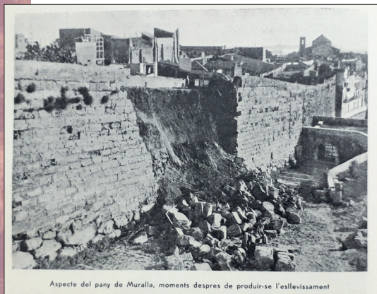
Aspecte del pany de Muralla, moments després de produir-se l'esllavissament
