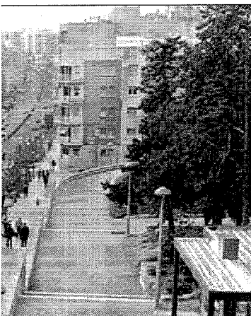
A l'extrem esquerre, obres de prolongació de l'avinguda, que s'iniciaren l'any 1971.
