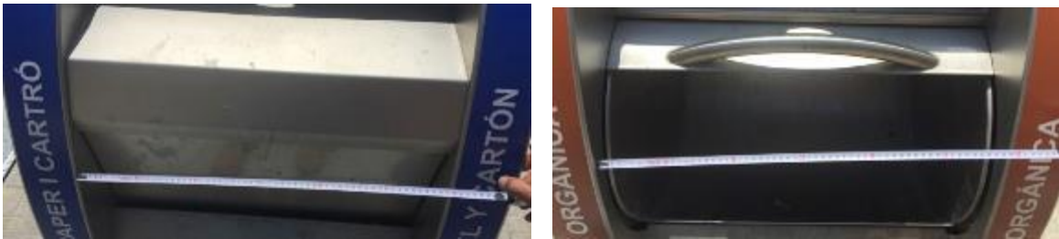
Figura 21. Boca dels contenidors de paper-cartró (60 cm) i FORM (60 cm) soterrats de càrrega superior VCONSYST - 1 Ganxo, sense tapa reductora.
