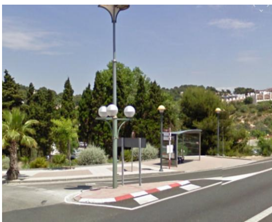
Parada d'autobús amb marquesina i amb voreres que permeten un accés còmode i segur a l'entrada de la Urbanització de Cala Romana.
