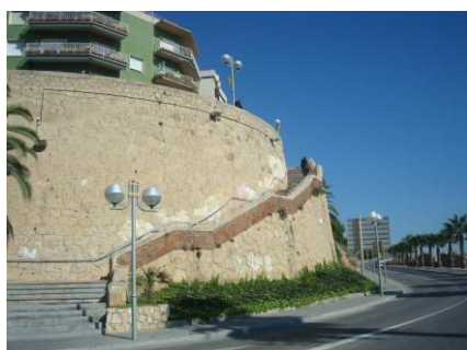
Accés a la Baixada del Toro mitjançant escales. Permeten connectar l'estació de ferrocarril i passeig marítim amb el centre de la ciutat.
