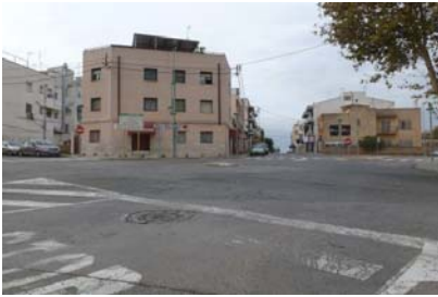
Intersecció del carrer Gaià amb Francolí. Hi ha un petit illot que no queda clar si és rotonda ni tampoc qui té prioritat de pas. És un punt d'inseguretat destacat.
