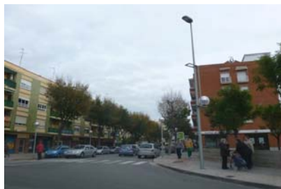
Intersecció de Sant Benilde amb Riu Fluvià, novament en rotonda i amb pas de vianants parcialment ocult pels vehicles i sense refugi central ni senyal vertical.
