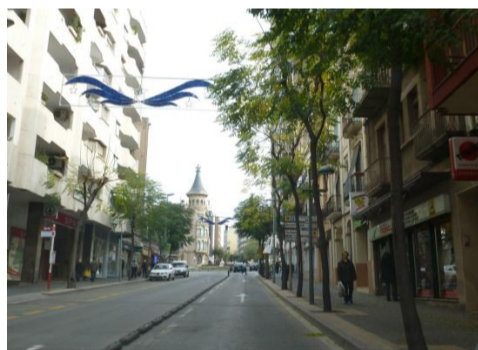
Tram proper a la Font del Centenari, a la Rambla Nova. Hi ha un carril en sentit centre i un altre en sentit contrari, a més d'un espai de parada de bus. La separació dels sentits es fa amb peces de cautxú per evitar avançaments de motos pel sentit contrari.
