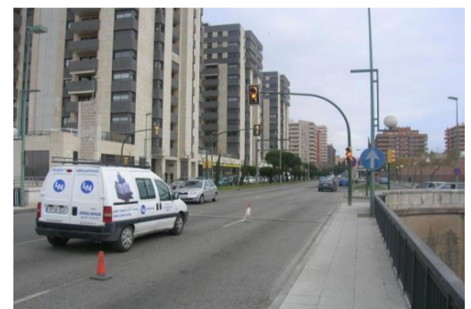
Pont sobre el Francolí
