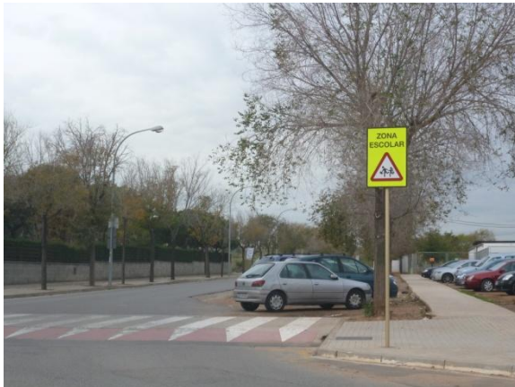
Imatge 61. Pas elevat i senyalització vertical.
