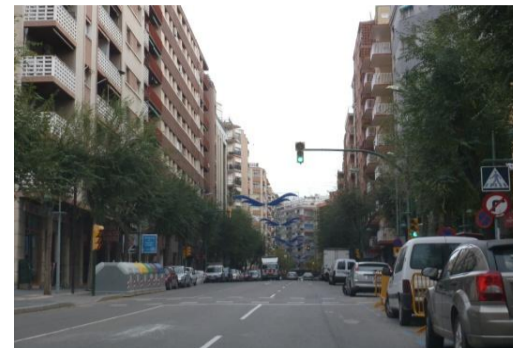
Intersecció amb Francesc Bastos. Hi ha contenidors abans del pas en sentit est que en cas que no funcioni el semàfor poden dificultar la visibilitat dels vianants.
