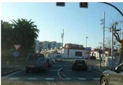
Rotonda d'enllaç amb l'avinguda d'Andorra. Hi ha un by-pass (amb separadors) per anar d'av. Catalunya direcció Valls. La rotonda és molt petita i amb trànsit elevat.
