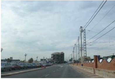
Final del tram de calçada lateral i carrils centrals, per on els vehicles circulen a elevades velocitats.
