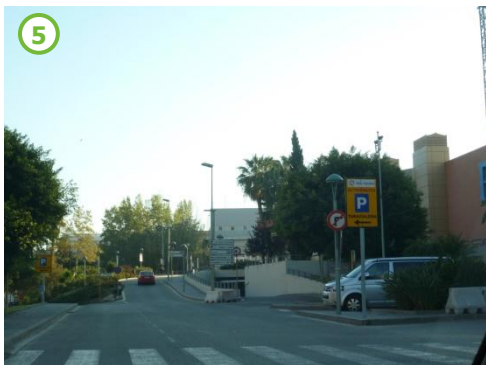
5 Lateral del costat oest, que dona accés als aparcaments del centre comercial del Parc Central. Hi ha dos carrils amb només uns 50 metres de longitud per fer els moviments de trenat corresponents.
