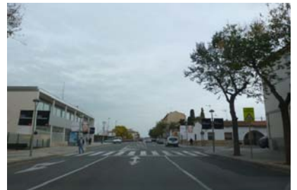
Sentit est, intersecció amb el carrer Montblanc. La senyalització horitzontal del carril central pot induir a confusions. El pas de vianants no està senyalitzat verticalment (senyal S-13).
