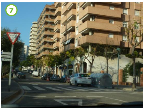
7 L'entrada al lateral est des del tronc central de l'avinguda Vidal i Barraquer es fa amb un senyal de cedir el pas. L'amplada existent en el tram de dos carrils propicia estacionament irregular al carril de circulació.
