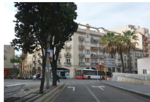
Sortida de la Via de l'Imperi Romà a la Rambla Vella. El doble carril per girar a l'esquerra pot provocar friccions entre els vehicles.
