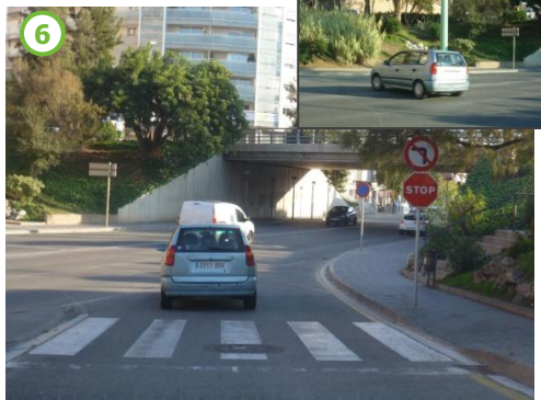
6 Accés del lateral oest a l'avinguda Vidal i Barraquer sentit sud. Tot i estar prohibit sovint s'observen vehicles que giren directament a l'esquerra.
