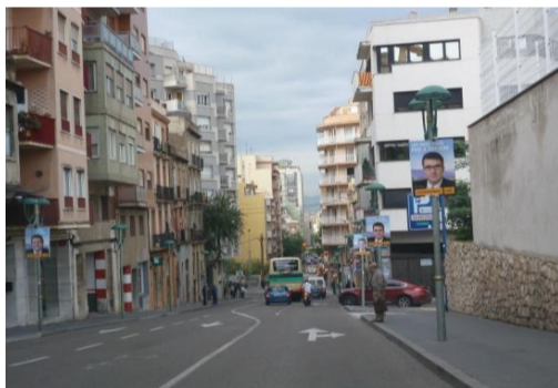
Estanislau Figueras amb Josepa Massanes. En aquest punt mancava un pas de vianants per creuar el carrer, tal com es proposava, i que no s'ha executat.
