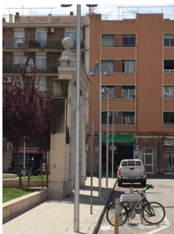
Estat de deteriorament de l'arc De Muller.
