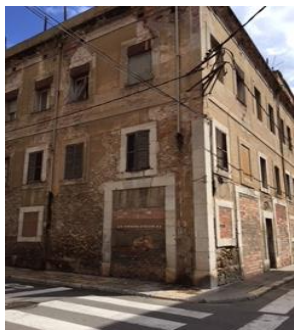
Edifici de titularitat municipal ubicat a la cruïlla entre els carrers Pau del Protectorat i Santian.
