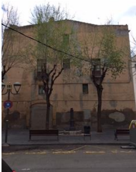
Exemple d'uns dels cables penjant d'una façana a una altra.
