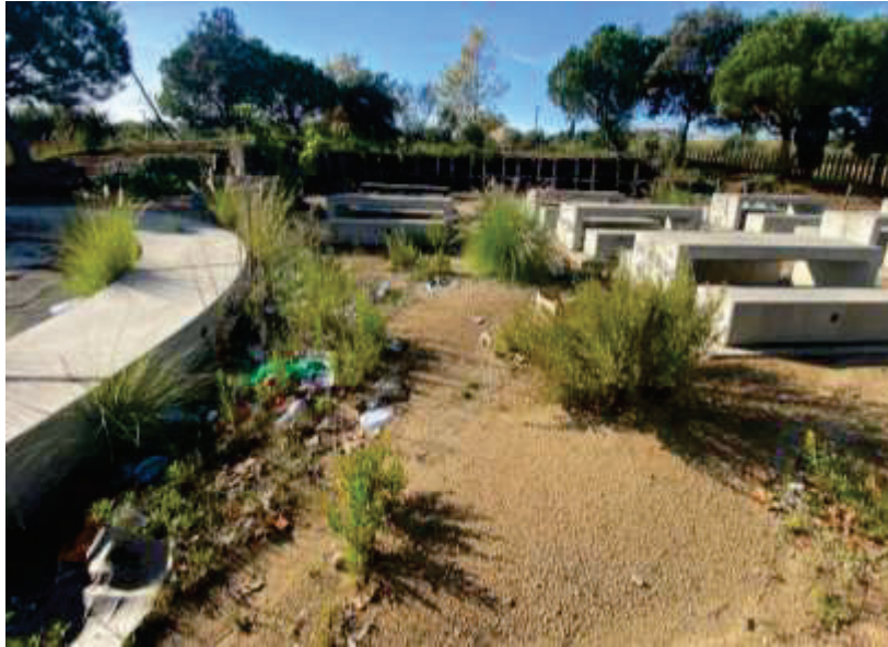
Estat actual de degradació del Parc de la Coma.
