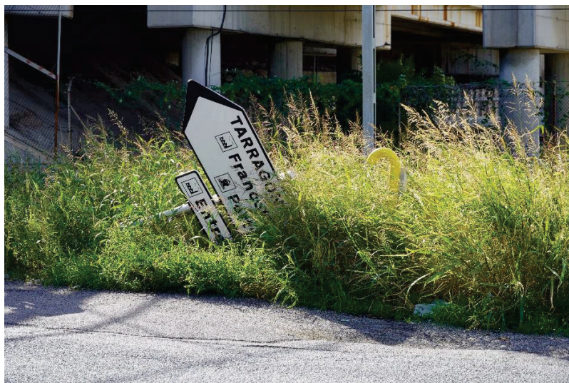
Imatge 2. Estat lamentable de les senyals verticals de trànsit
