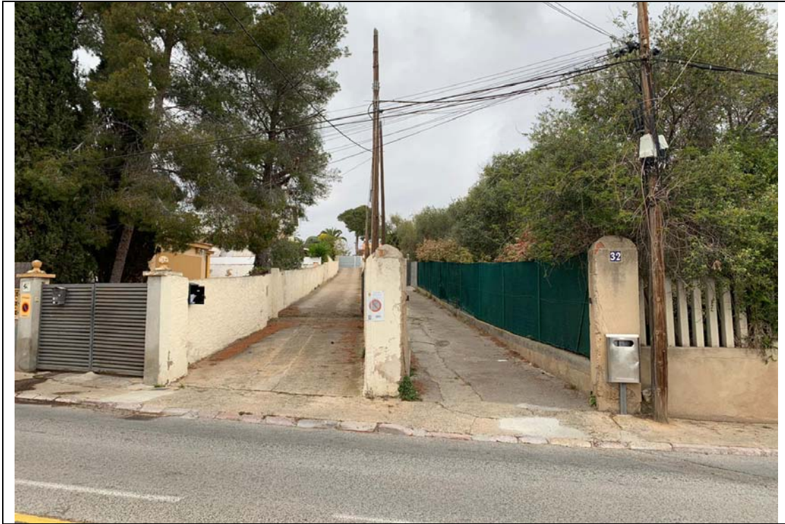
Vista dels dos vials existents en el punt d'accés (Passeig Rafael de Casanova)
