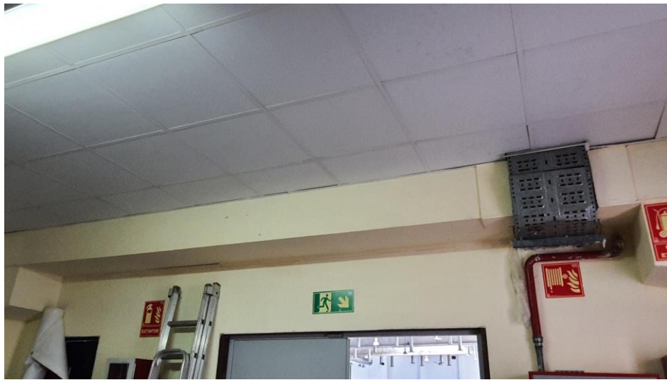
Baixant de coberta entrant al fals sostre del magatzem
