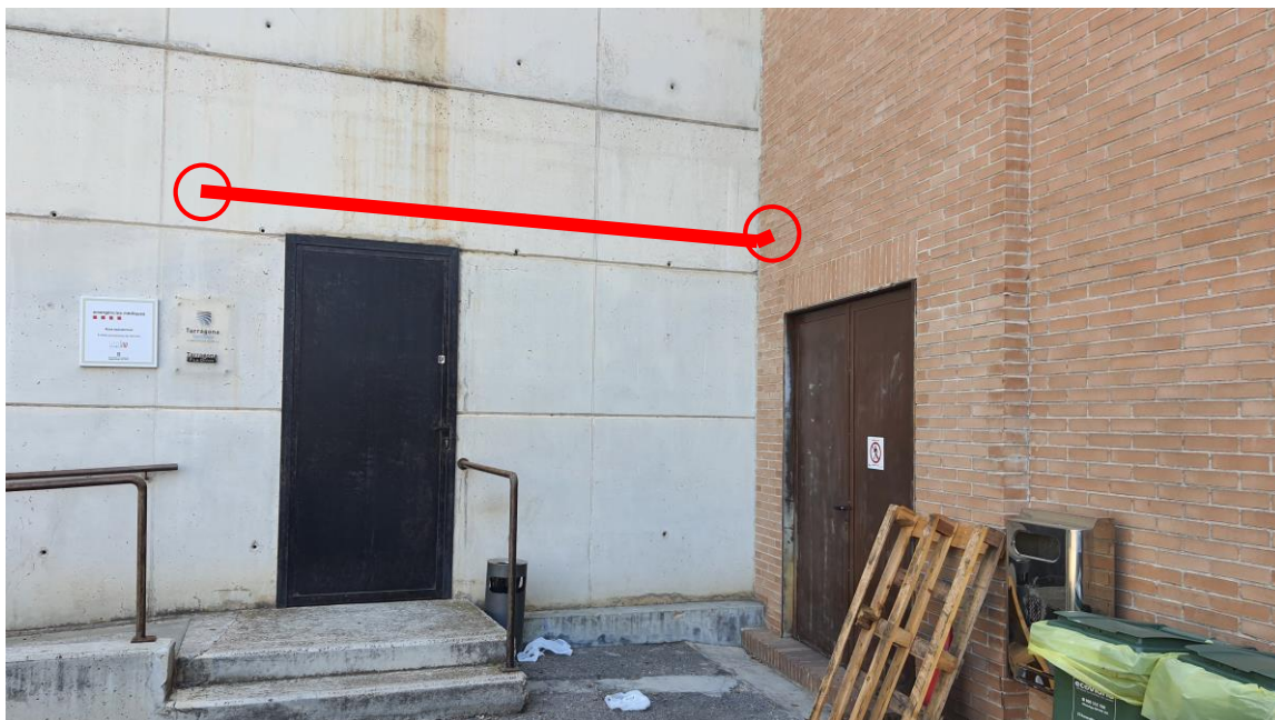
Recorregut per l'exterior del cablejat, entre el magatzem i la galeria tècnica
