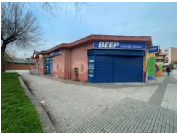
Elements de façana a desmuntar.
