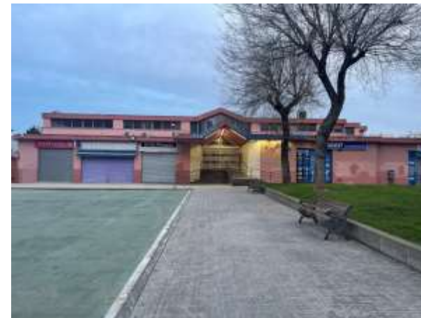
Façana lateral esquerra.
