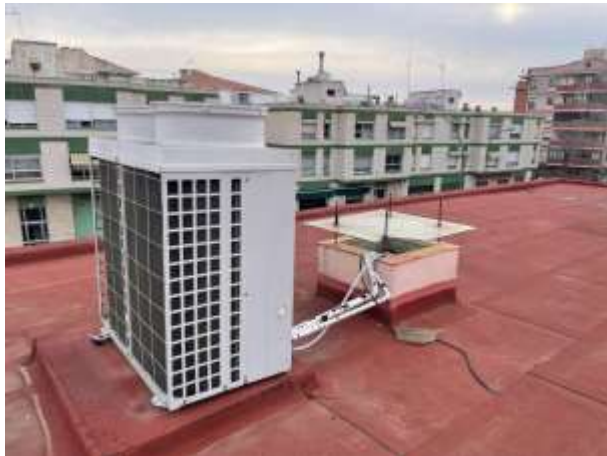
Claraboia coberta i màquina climatització.
