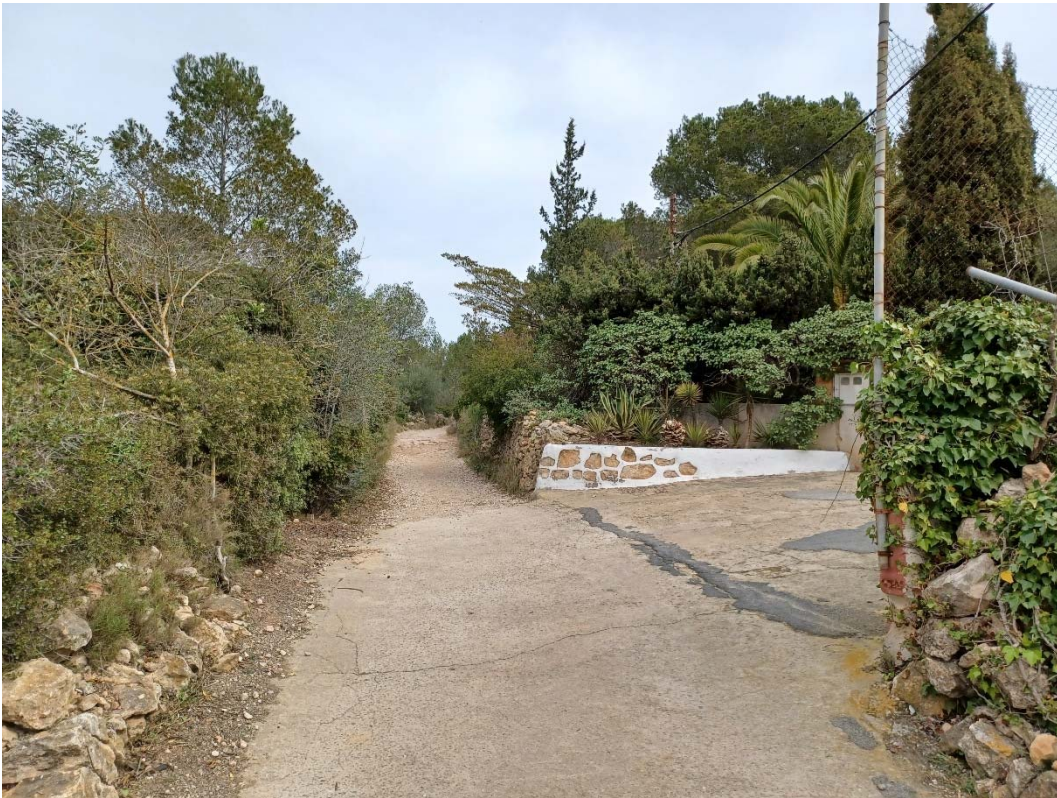
FOTO N° 13. Vista de l'entrada existent a la finca que resultarà afectada durant les obres.
