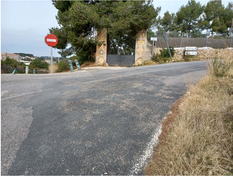
FOTO N° 1: Vista del punt d'inici (P.Q. 0+000) de les actuacions a la cruïlla del Camí Nou de la Budellera.
