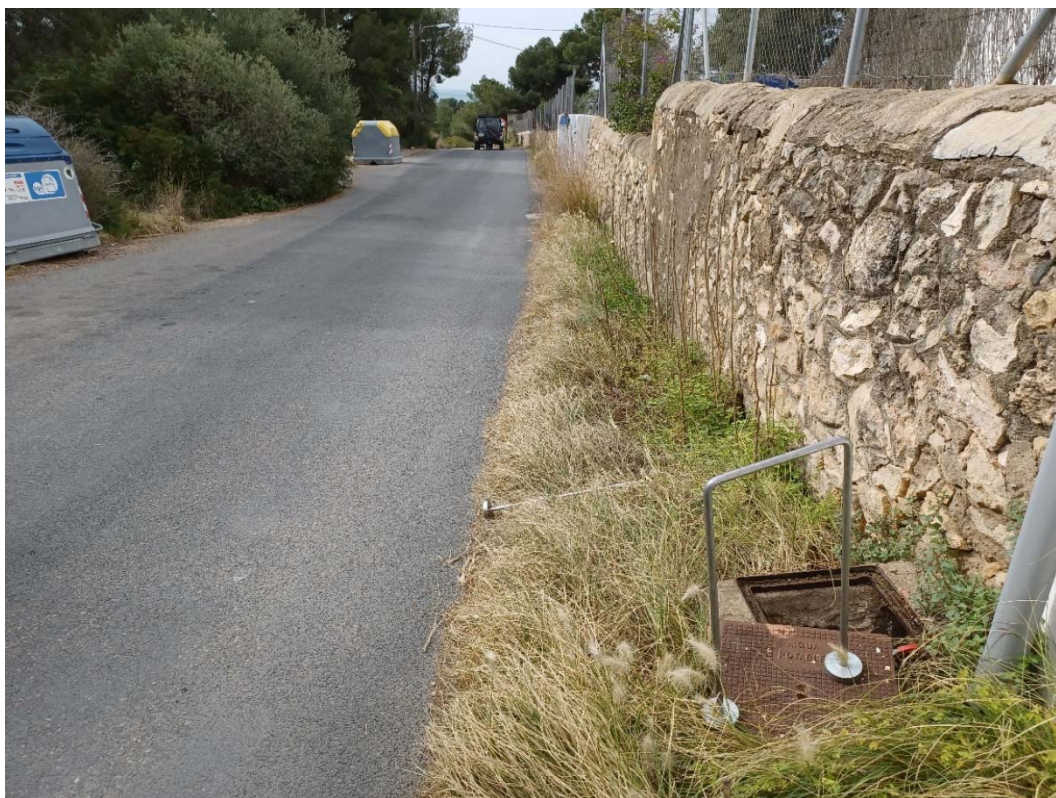
FOTO N° 4. Vista de la franja per on passarà el traçat al voltant del P.Q. 0+080.
