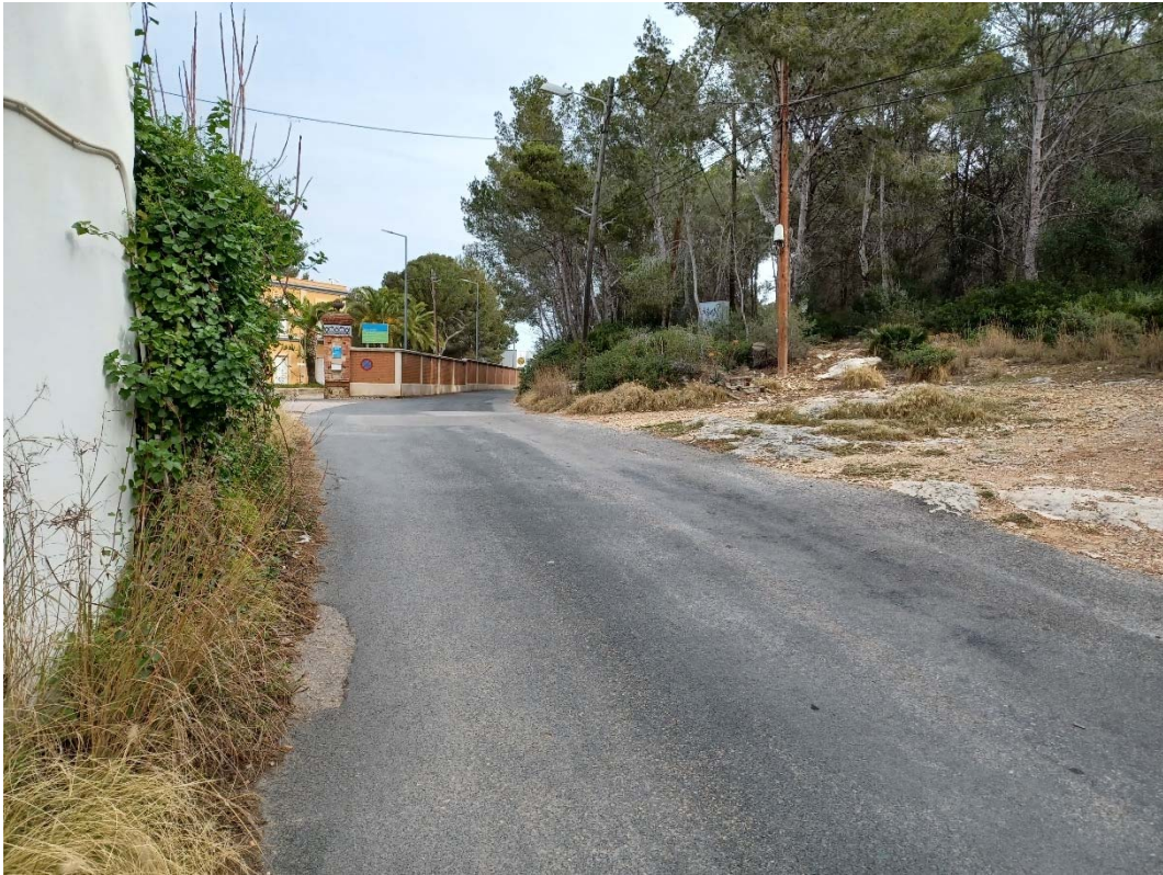
FOTO Nº 5. Vista del tram d'accés al CIDO, al voltant del P.Q. 0+090.
