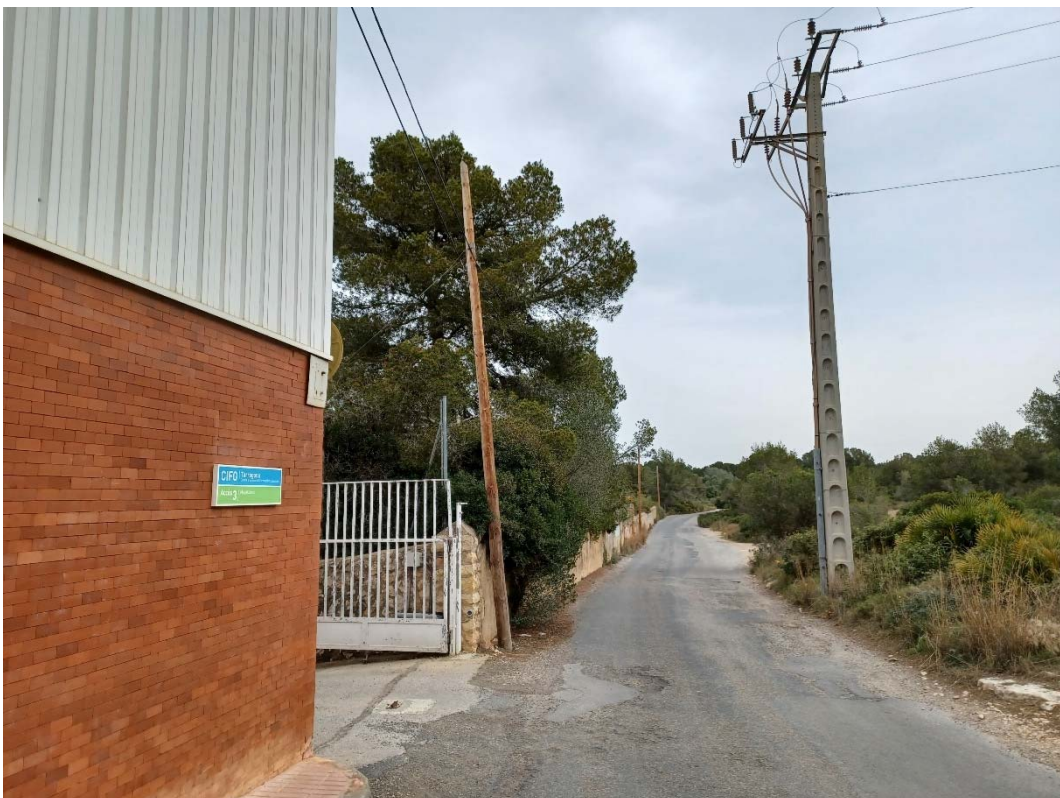
FOTO Nº 8. Vista de la torre elèctrica on es hi ha la conversió aèria-soterrada de la línia de MT que entra a la E.T., en el punt on les canonades hauran de minar sota el servei.
