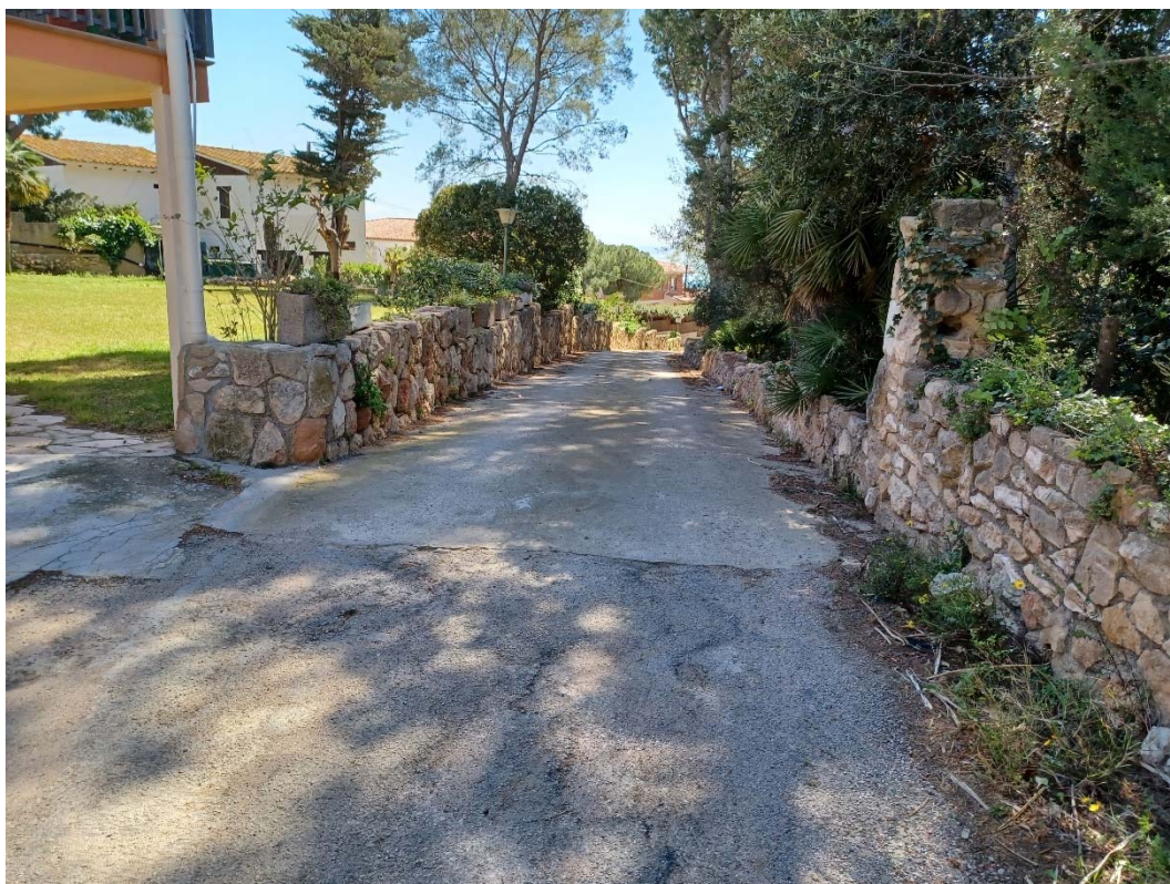
FOTO N° 22: Vista de l'inici del tram del camí privat de Mas Sanromà, al P.Q. 0+940.
