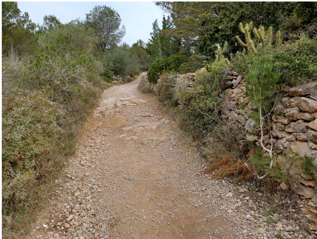
FOTO N° 14. Vista del pas del tram estret del camí nou de la Budellera, on s'hi troben murs de pedra seca amb possible afectació.
