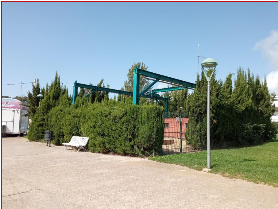
Fotografia nº 2: Vista zona accés a EB La Mora, mobiliari urbà i il·luminària afectada per l'ampliació.
