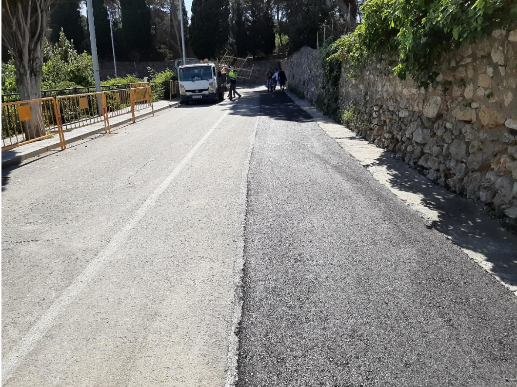
FOTO N° 9. Vista de la calçada del Passeig de Torroja en el tram on s'ubicava el massís de fonamentació del suport del tram de l'antic traçat de la línia elèctrica aèria i la seva conversió a soterrada.
