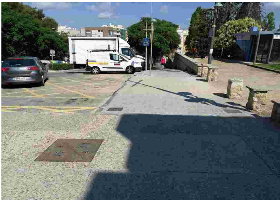
FOTO Nº 2: Paviment en vorera que es veurà afectat amb la futura actuació de les noves canonades de distribució de FD200 i FD400 de la zona d'actuació nº1.
