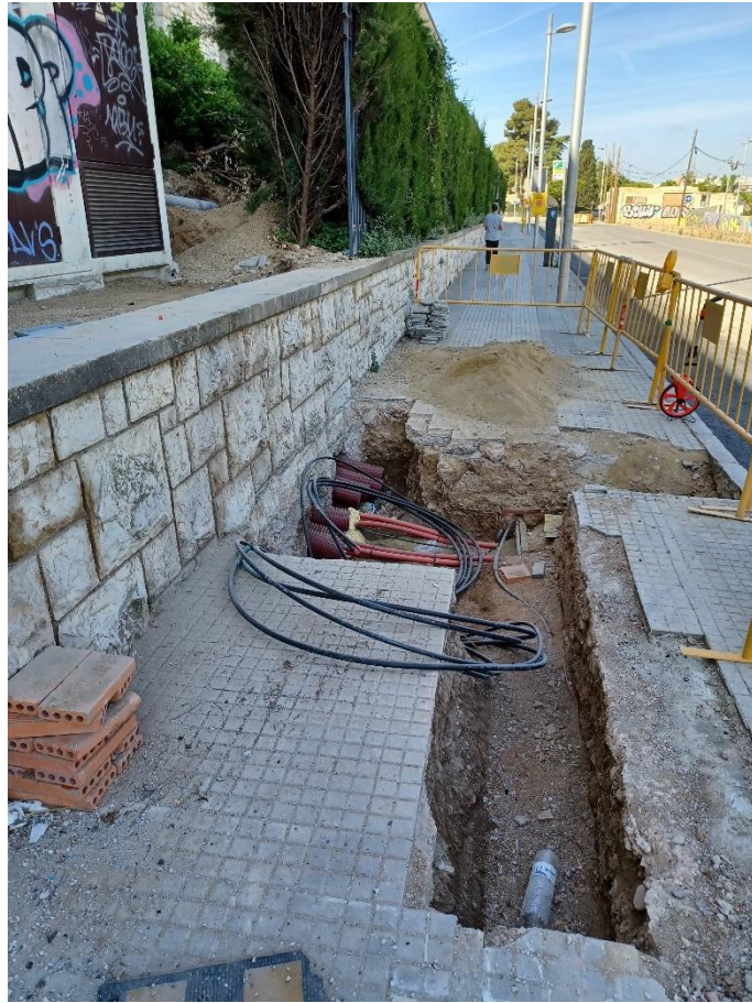
FOTO Nº 5. Vista del tram de vorera del Passeig de Torroja per on cal fer la rasa. Es mostra les actuacions d'estesa elèctrica de MT 25kV que ENDESA ha realitzat mentre es feia la revisió del present projecte.
