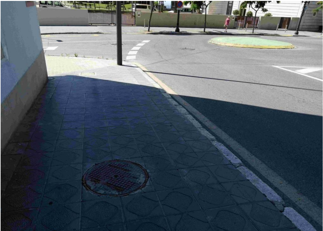
FOTO Nº 19. Vista Passeig de Torroja cantonada amb Passeig St. Antoni. Vista d'arqueta vàlvula i final de tram d'actuació nº2 on es connexionara amb la canonada existent.
