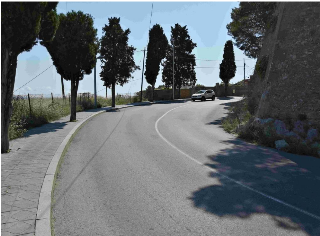
FOTO Nº 12. Vista Passeig de Torroja, zona del traçat per on la canonada anirà pel costat esquerre.
