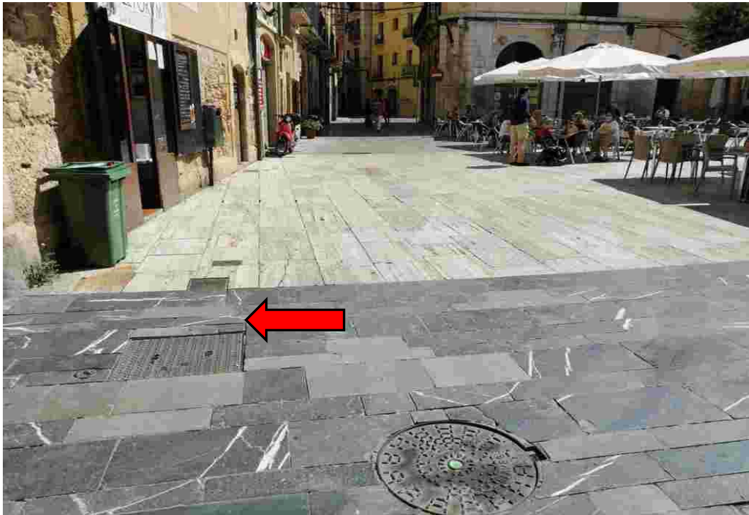
FOTO N° 23: Vista carrer Merceria cantonada amb plaça del Fòrum. Arqueta amb vàlvula existent. Nova connexió, vista d'un costat del carrer. Zona d'actuació n°5.
