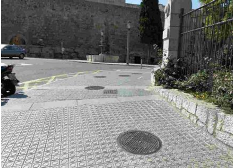
FOTO Nº 1: Vista de la Av. Catalunya, vorera parc de Saavedra, punt de la nova connexió de la zona d'actuació nº1: Av. de Catalunya - Av.Maria Cristina.
