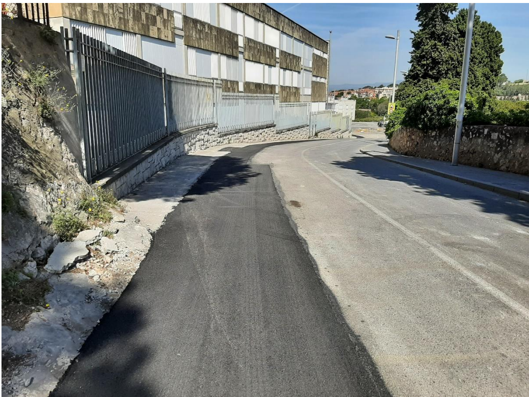
FOTO N° 8. Vista de la calçada del Passeig de Torroja en la part final del mur perimetral del Col·legi Sant Pau. S'observa l'amplada variable de la rasa que conté la nova línia elèctrica de MT de 25kV d'ENDESA.
