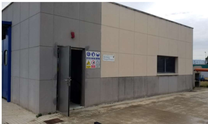
Foto 6 Edifici bombeig fang primaris. Alçat Frontal.
