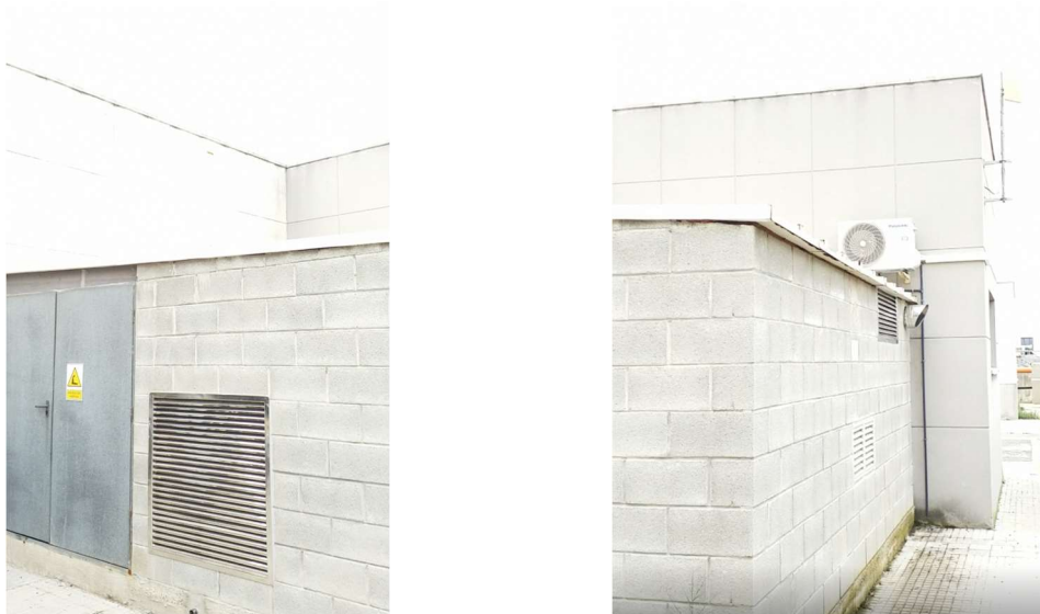
Foto 3 Sala del grup electrogen pretractament adossat a la sala del quadre elèctric.
