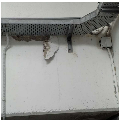
Foto 9 Tros de muret /Llosa forjat fossat .
