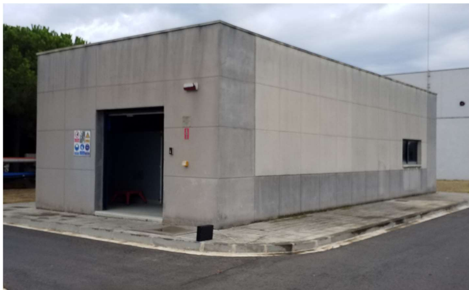
Foto 18 Vista exterior Edifici Alta Tensió.
