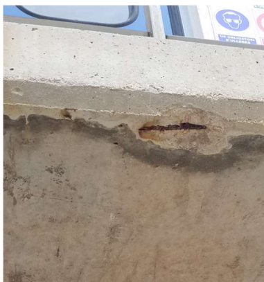
Foto 17 Desperfectes en escala de formigó en Edifici Cargols.
