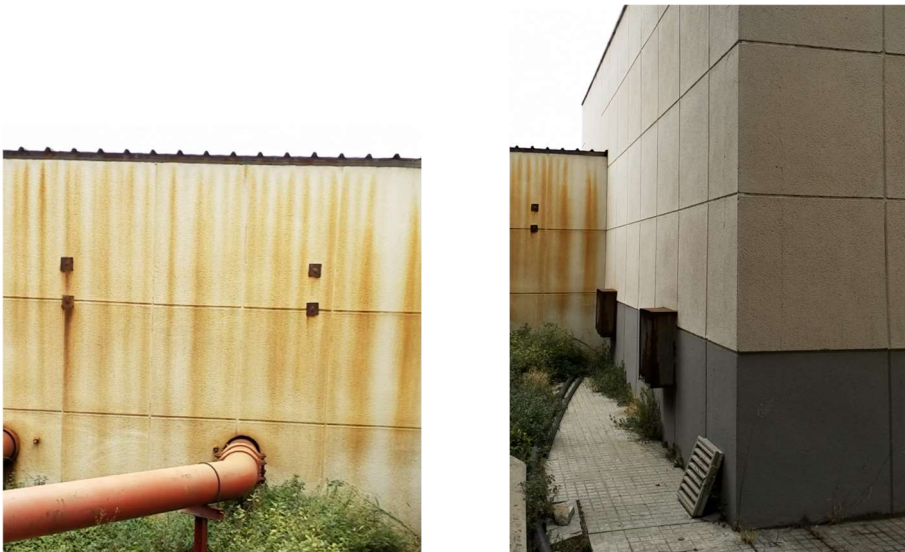
Foto 2 Estat façana posterior sala grups antiincendis.
