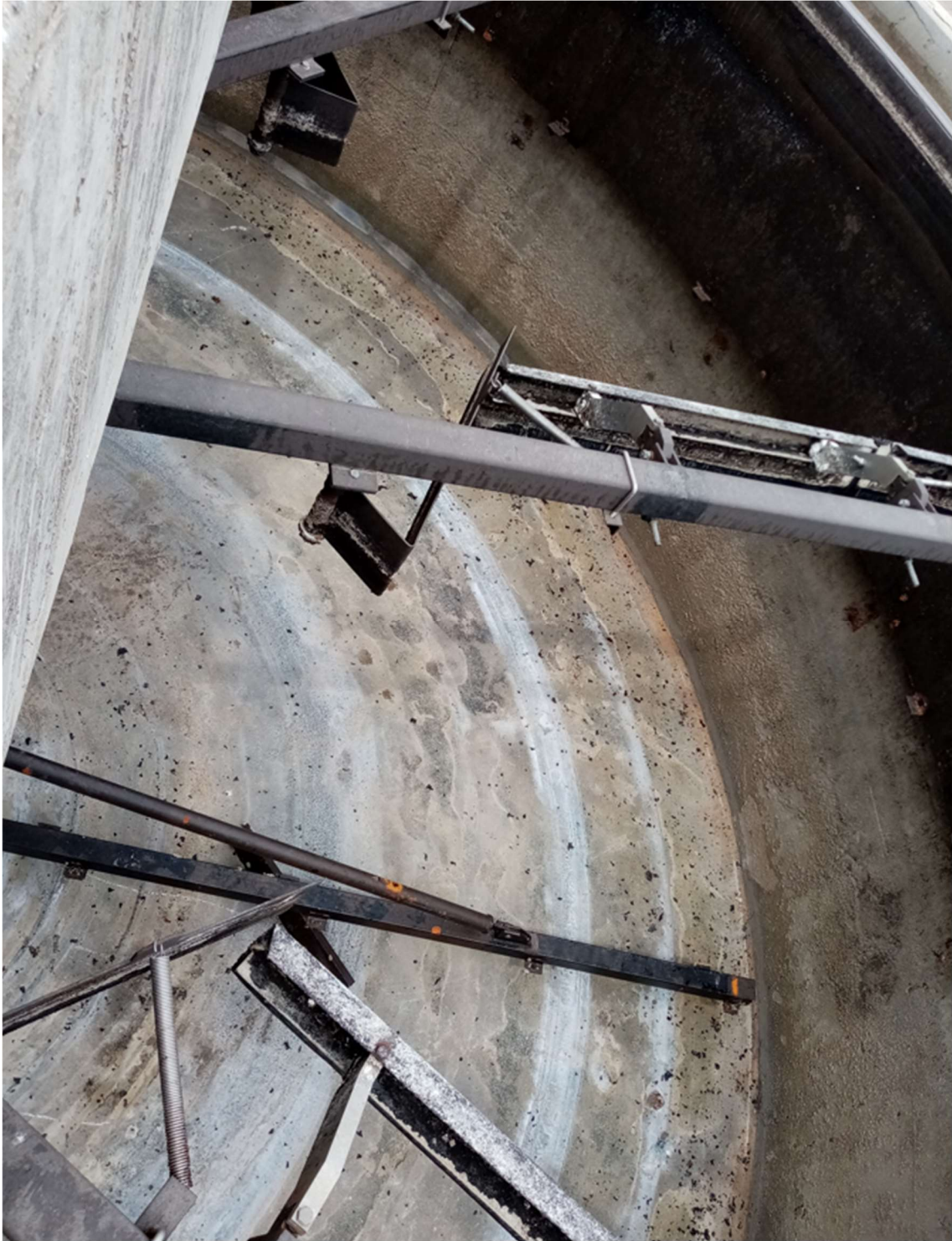
Foto 10 Revestiments de murs interiors
