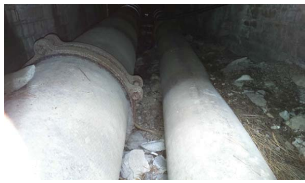
FOTO 6: Vista de les dues canonades dins del caixetí paral·lel a les escales, la de diàmetre 300 mm i la de diàmetre 200 mm "Bonavista", segons es mostra en els plànols.
