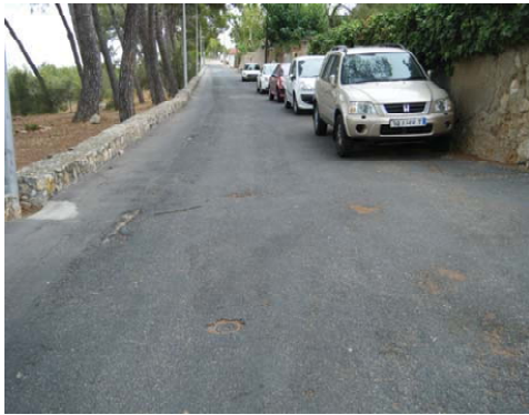
FOTO 3: : Vista de la vàlvula de seccionament existent en la calçada, la maniobra de la qual es mantindrà amb la present actuació
