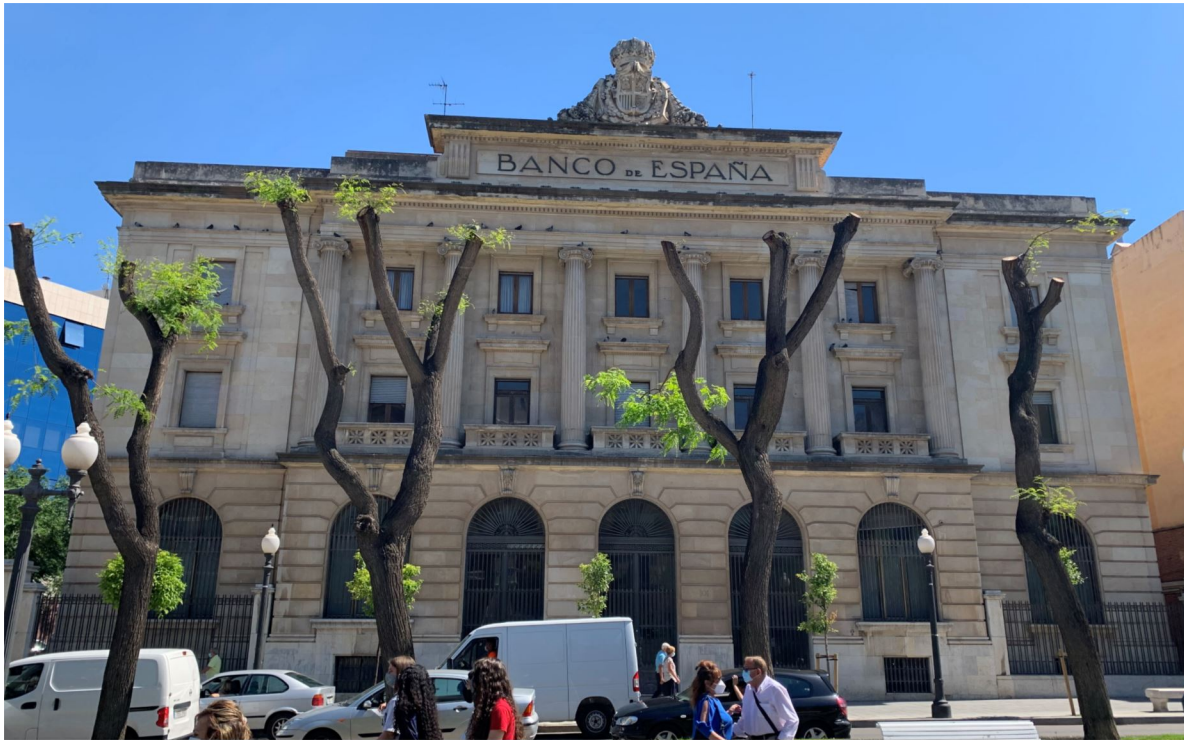
7700435509 Façana Banc del Coneixement
