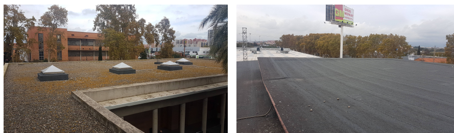
Ilustración 4. Cubierta de edificio Tanatorio de Tarragona. Izquierda acabado en grava y derecha en butilo
