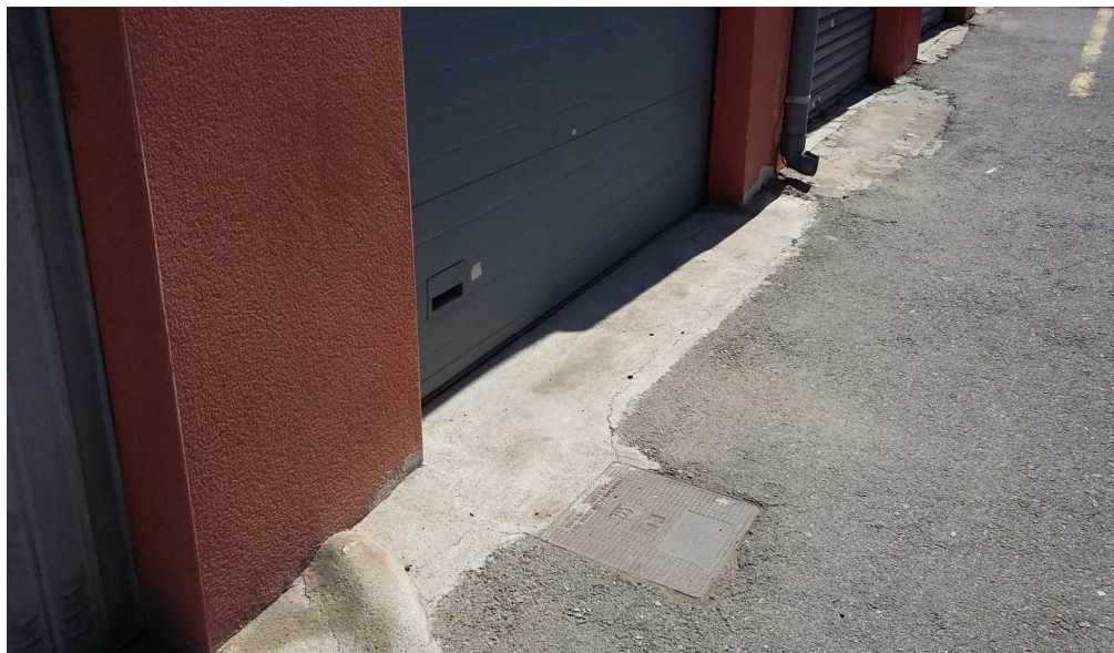
FOTO Nº 17: Serveis existents a la zona on estarà la rasa de la canonada.
