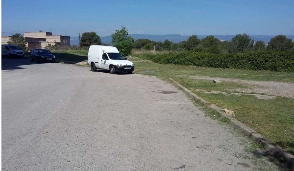
FOTO Nº 19: Vista de l'últim tram de la nova canonada d'aigua. Punt que es deixarà preparat per donar continuïtat a la canonada al moment s'activin les obres de la segona fase.
