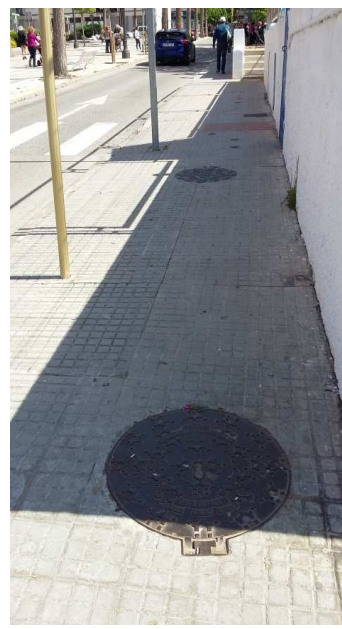
FOTO Nº 9: Xarxa de clavegueram que creua el vial per on està previst el traçat de la canonada d'aigua.
