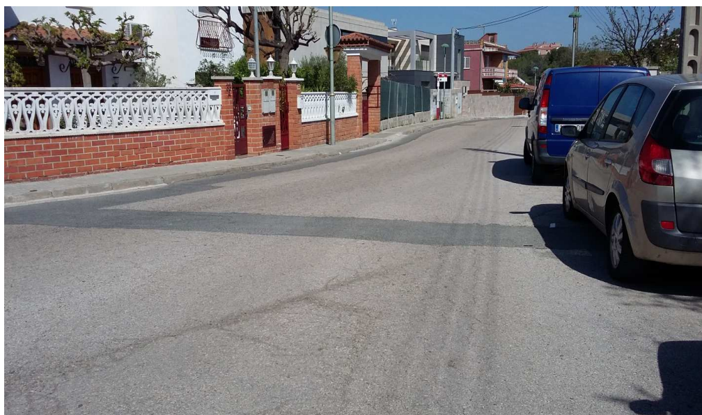
FOTO Nº 2: Vista del tipus de paviment asfàltic en calçada que es veurà afectat amb la futura actuació.
