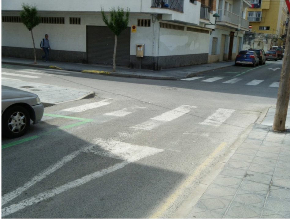
FOTO N°7: Vista de marques vials a tornar a pintar en carrer Nou de Santa Tecla.
