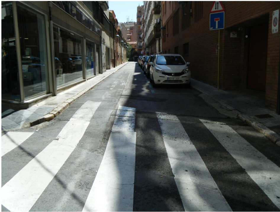
FOTO N°1: Inici del tram d'actuació en el Passatge Fornes, on el col·lector de clavegueram de 300 mm de diàmetre connecta amb el pou de registre del carrer de Sevilla.
