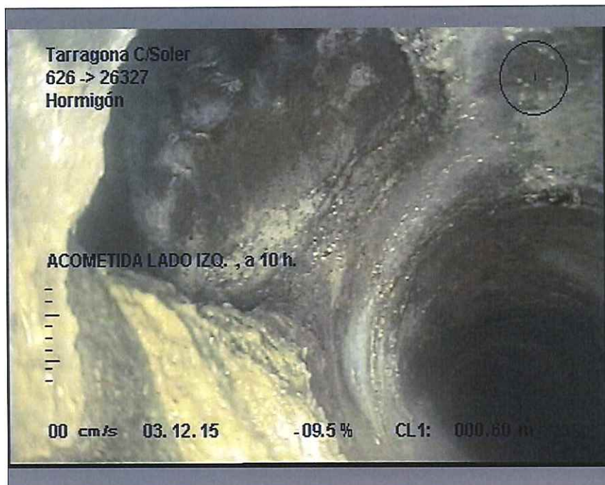
Foto: 8_3A, MPEG #: 021215_1, 00:00:25 0,6m, ACOMETIDA LADO IZQ. , a 10 h.
