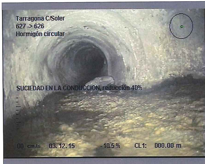
Foto: 9_4A, MPEG #: 021215_1, 00:00:53 1m, SUCIEDAD EN LA CONDUCCION, reducción 40%
