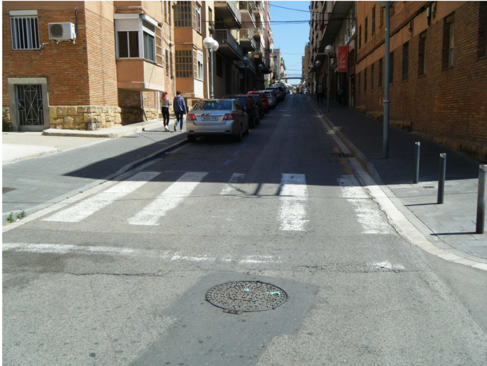
FOTO Nº1: Vista del pou de registre de inici del tram de renovació del col·lector de formigó de 400 mm de diàmetre, en el tram del carrer de Soler des del carrer dels Caputxins.
