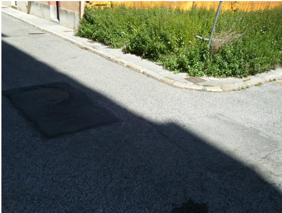
FOTO N°5: Vista de l'últim pou de registre en el tram de renovació del Passatge Forns.
