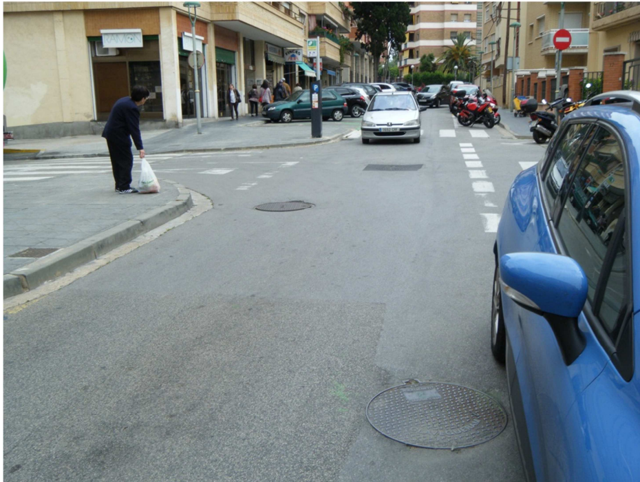
FOTO N°3: Vista dels dos pous de registre que defineixen el tram de col·lector de formigó de diàmetre 400 mm previst a inutilitzar aprofitant l'altre en paral·lel de diàmetre 600 mm.
