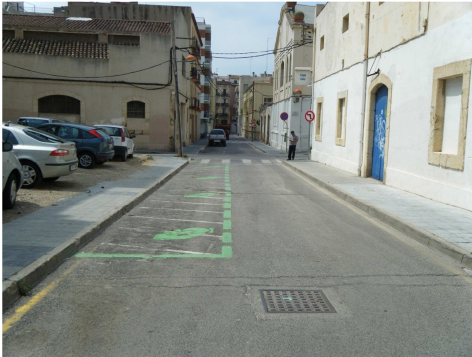
FOTO N°5: Vista del carrer Nou de Santa Tecla on existeixen dos pous de registre de clavegueram del col·lector a renovar.
