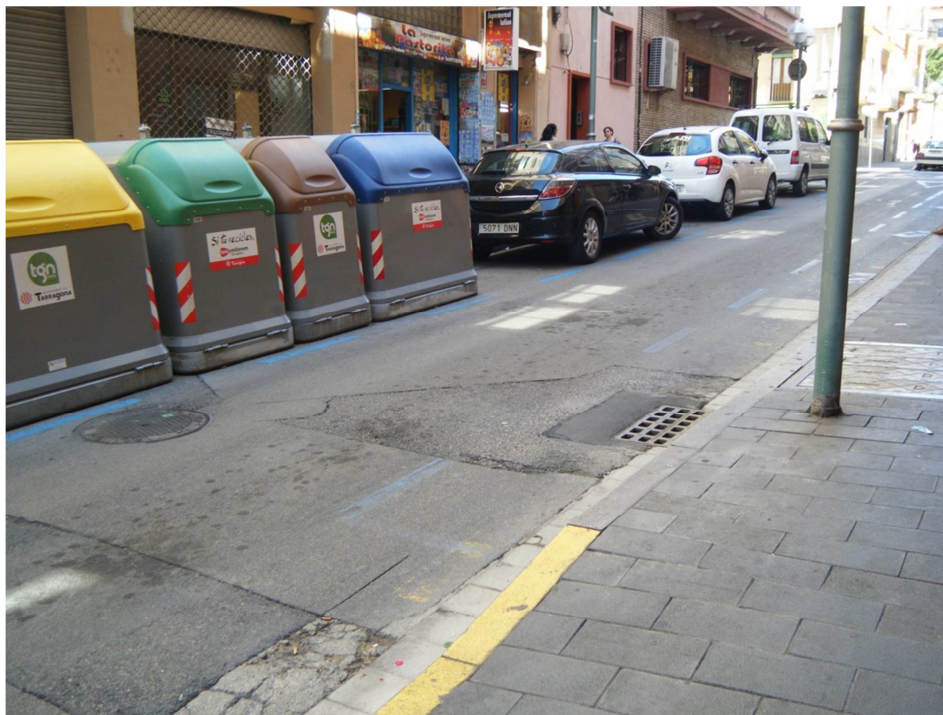
FOTO N°4: Un dels dos pous de registre que es renovaran per un altre de material plàstic, PVC corrugat.
