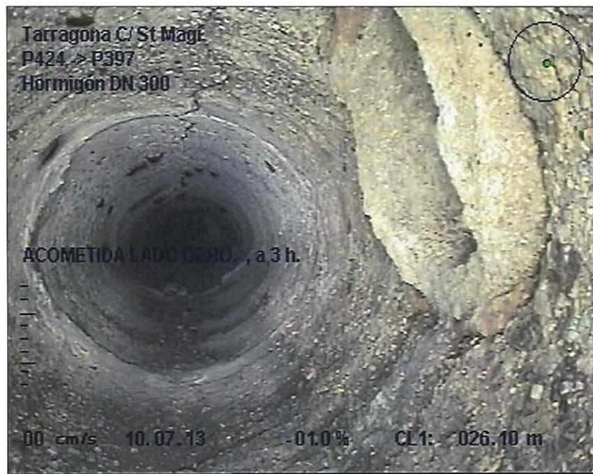
Foto: 6_6A, MPEG #: 110713_1, 00:02:26 26,1m, ACOMETIDA LADO DCHO. , a 3 h.
