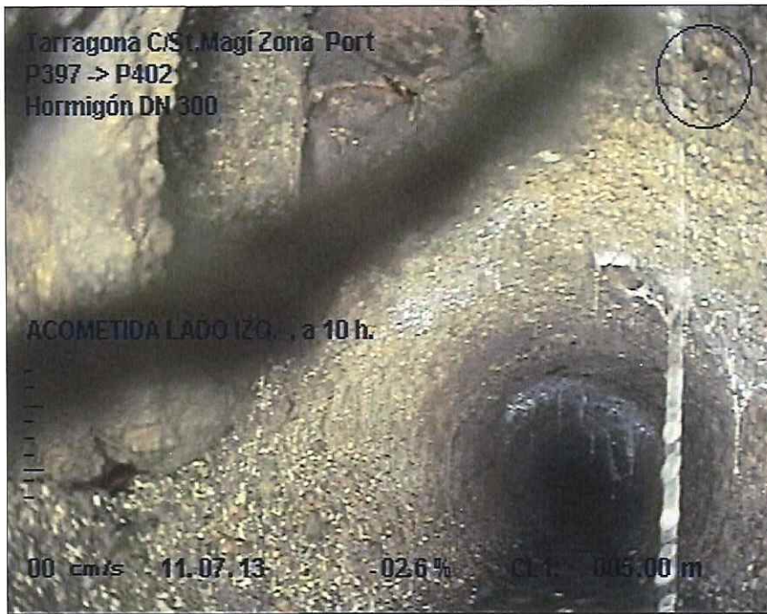
Foto: 7_4A, MPEG #: 110713_1, 00:00:36 5m, ACOMETIDA LADO IZQ. , a 10 h.
