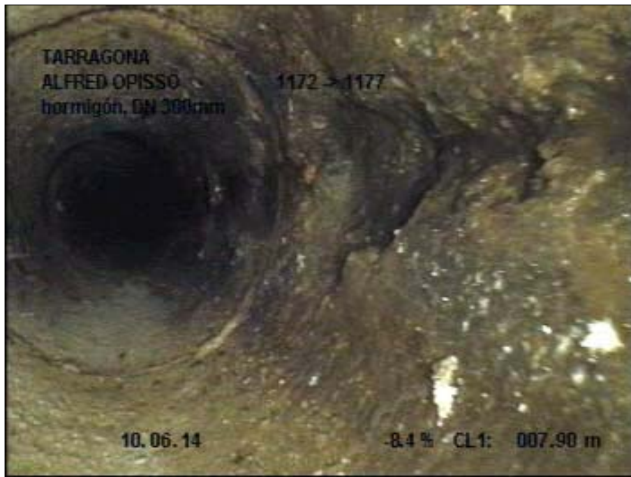
Fotografía: 2_2a, 00:02:43 7,9m, Desgaste mecánico desde 12 hasta 12 horas
