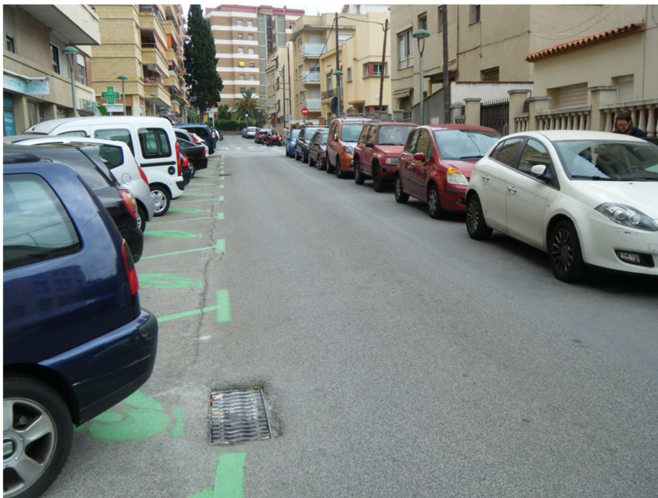
FOTO N°4: Tram de carrer Florenci Vives, entre carrer Escipions i Alfred Opisso, on els embornals estan situats en el marge del carril de circulació i no en el límit de la calçada amb la vorera.
