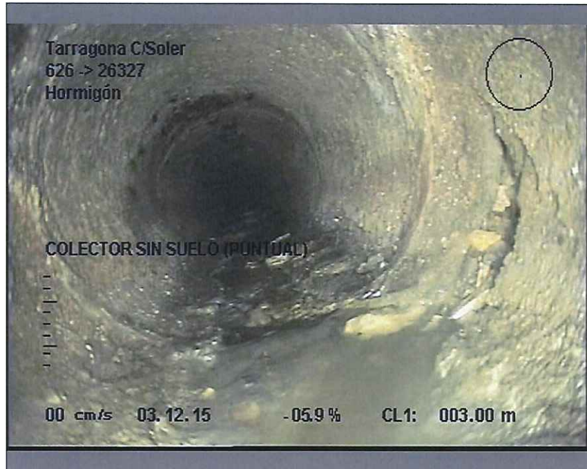
Foto: 8_5A, MPEG #: 021215_1, 00:00:58 3m, COLECTOR SIN SUELO (PUNTUAL)
