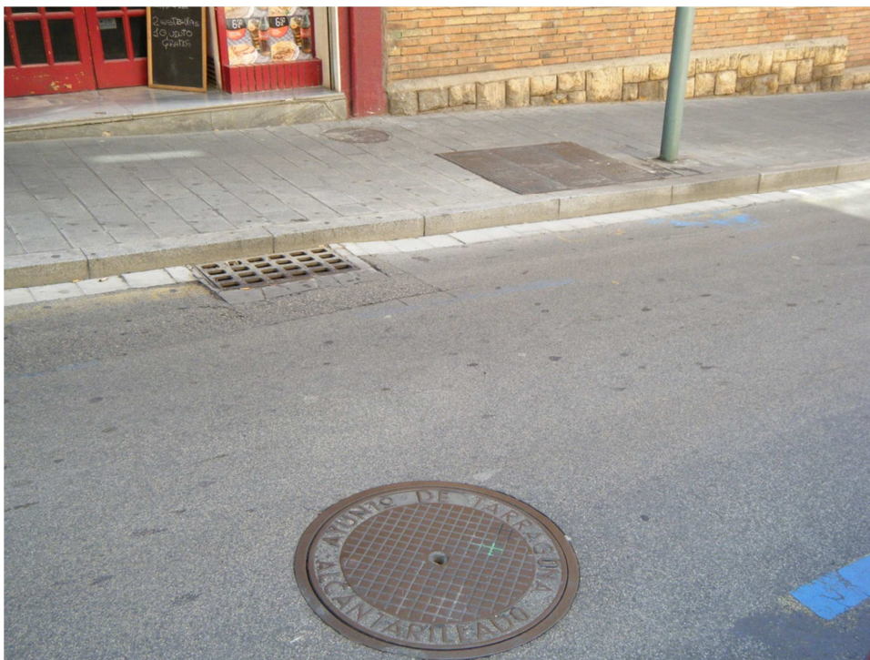
FOTO Nº2: Vista d'alguns dels seveis existents en el tram d'actuació del present projecte com són; telefonia, alumbrat públic, clavegueram, entre uns altres.
