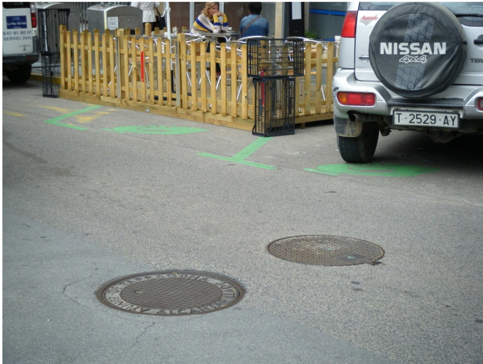
FOTO N°5: Punt on es poden veure els dos pous de registre pertanyents als col·lectors de 600 mm i 400 mm respectivament, que discorren en paral·lel pel carrer Florenci Vives.
