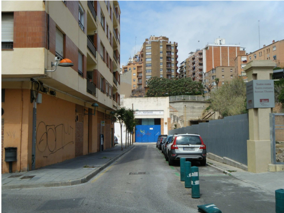
FOTO Nº1: Vial amb paviment asfàltic i rigola de formigó en el costat esquerre, a repavimentar, en el carrer Sant Magí amb el carrer de Misericòrdia.
