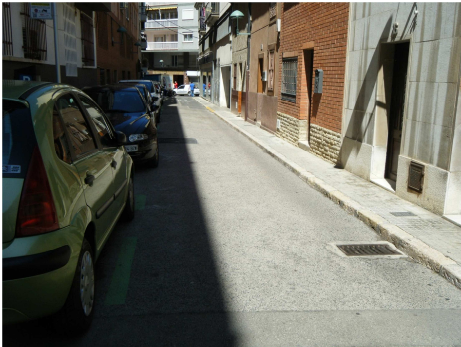
FOTO N°4: Embornal connectat a pou de registre de clavegueram.
