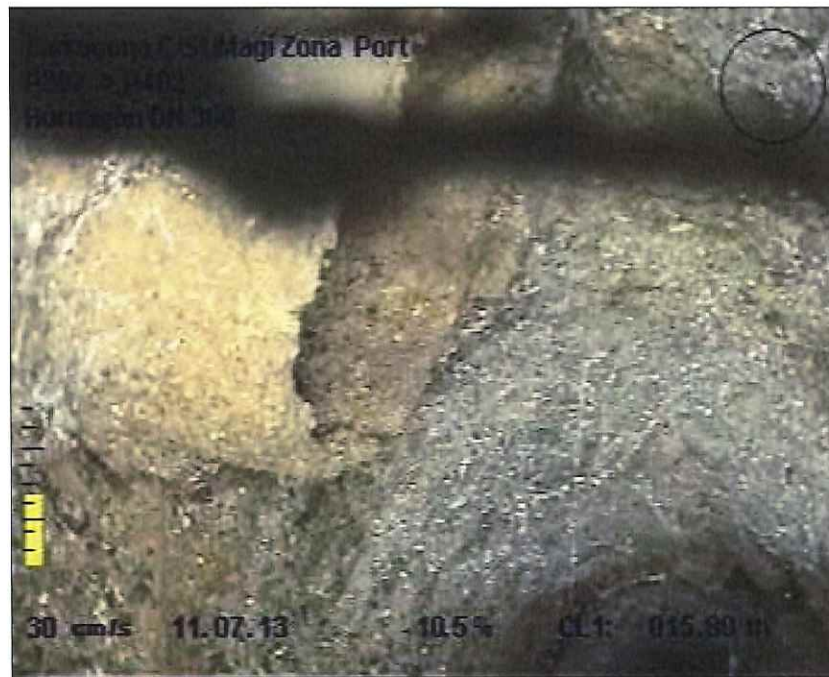
Foto: 7_6A, MPEG #: 110713_1, 00:01:32 15,8m, ACOMETIDA LADO IZQ. , a 10 h.
