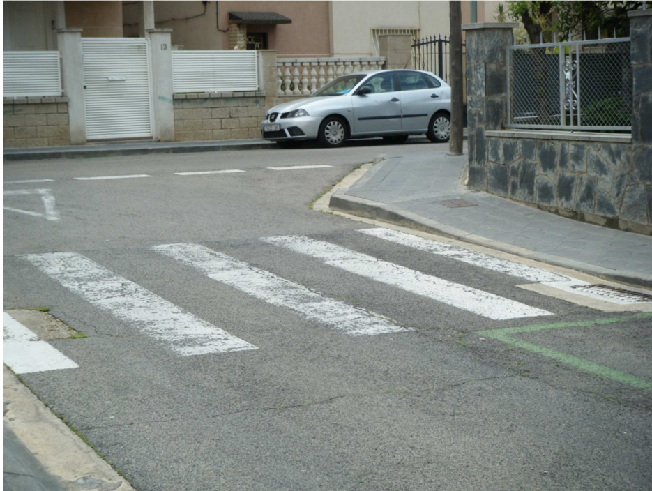
FOTO N°7: Secció tipus de calçada existent en tot aquesta àrea d'actuació, és a dir, vorera a banda i banda amb rajola hidràulica, vorada i rigola de formigó, i calçada de paviment asfàltic.
