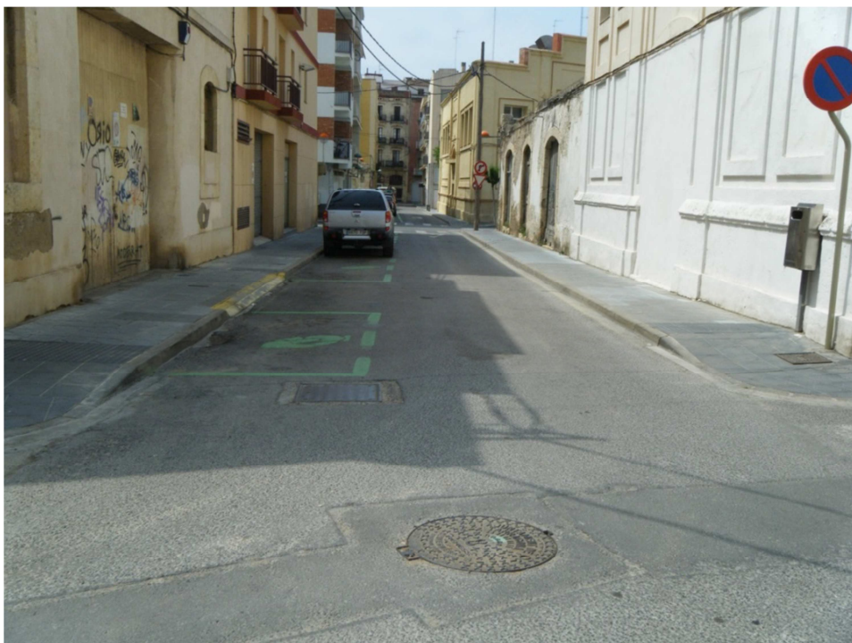
FOTO N°6: Vista del pou de registre on acaba el tram del col·lector de 300 mm de diàmetre de formigó, a canviar per un altre de PVC de diàmetre 400 mm.
