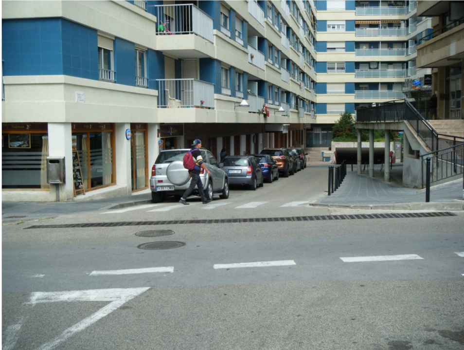
FOTO N°9: Reixa transversal de recollida de aigua de pluja en el límit del carrer Florenci Vives amb el dels Castellars de Tarragona, on es renovaran els claveguerons connectats al col·lector principal.
