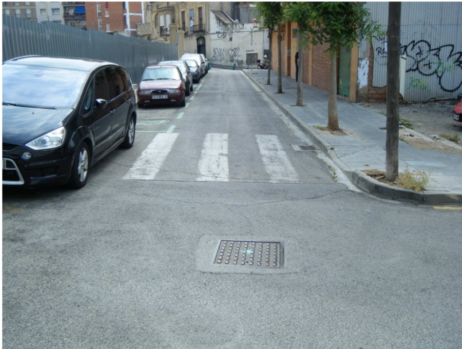
FOTO N°3: Vista d'embornal connectat a col·lector a renovar, en carrer Sant Magí amb carrer Nou de Santa Tecla.
