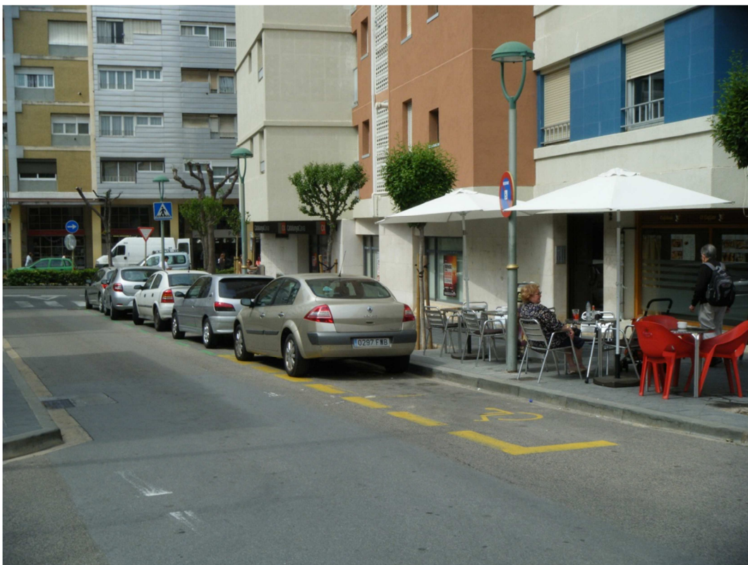
FOTO N°10: Carrer de Florenci Vives en sentit a l'Avinguda de Catalunya on es poden veure els embornals connectats a la red de clavegueram mitjançant pous de registre.
