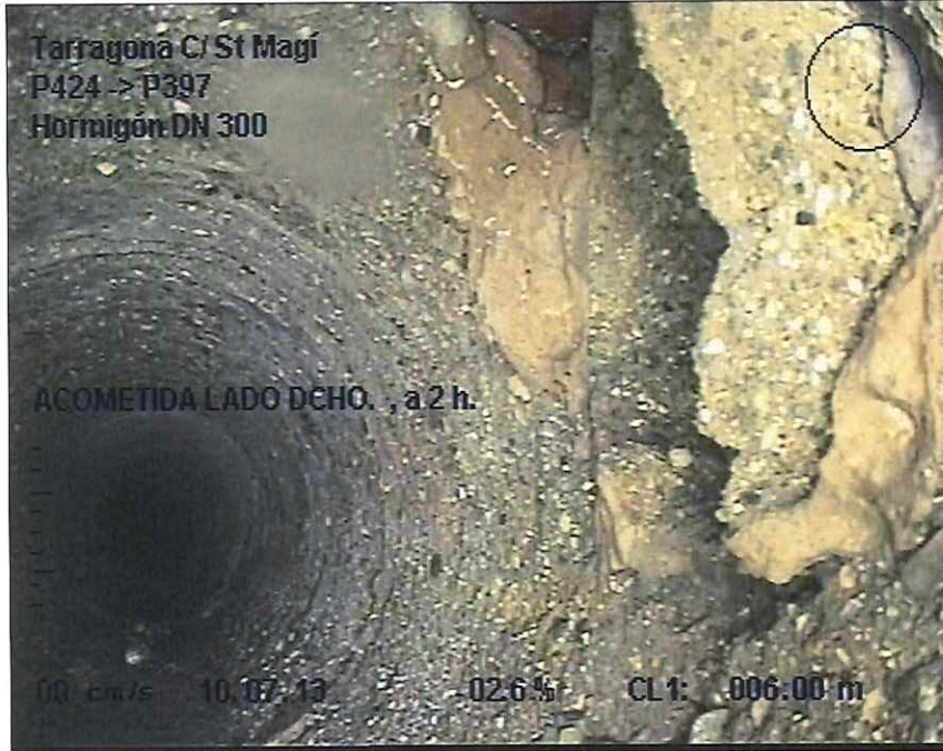
Foto: 6_3A, MPEG #: 110713_1, 00:00:30 6,4m, ACOMETIDA LADO DCHO. , a 2 h.
