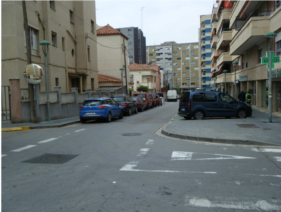
FOTO N°1: Vista dels dos pous de registre existents en el primer tram d'obra, el primer de clavegueram en el centre del vial i el segon de telefonia, en el carrer Florenci Vives.
