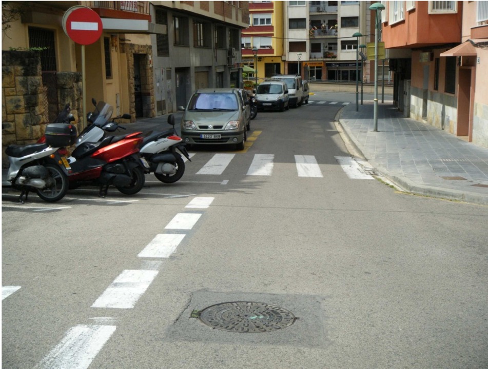
FOTO Nº11: Vista del serveis existents en vial i en vorera, en el carrer Monestir de Poblet des de Alfred Opisso fins a la Avinguda Catalunya .
