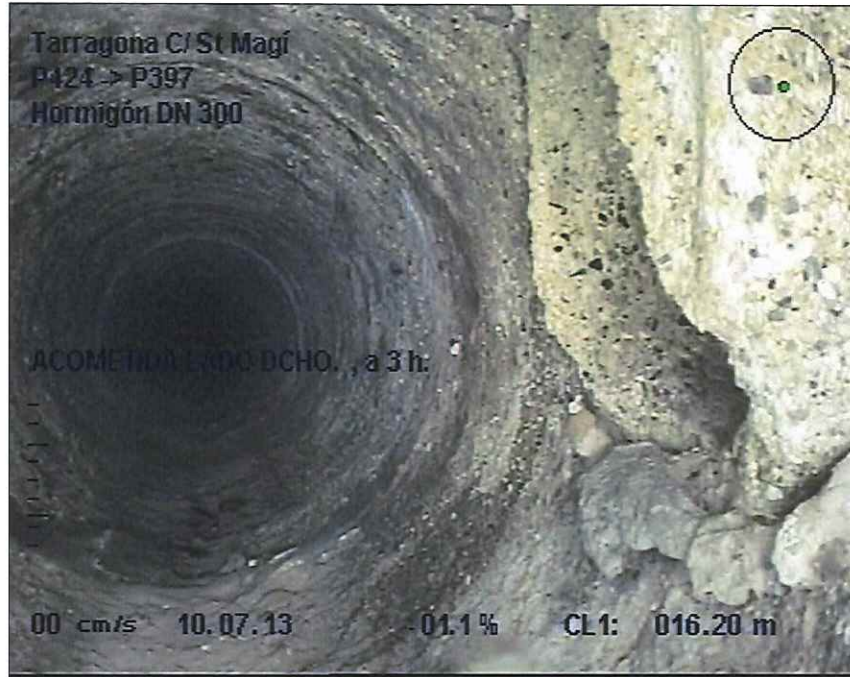
Foto: 6_5A, MPEG #: 110713_1, 00:01:41 16,2m, ACOMETIDA LADO DCHO. , a 3 h.
