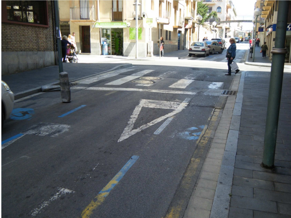
FOTO N°5: Secció tipus de calçada existent en tot el tram d'actuació d'aquesta zona, és a dir, vorera a banda i banda amb rajola hidràulica, vorada i rigola de formigó i, calçada de paviment asfàltic amb aparcament en línia en el costat esquerre.
