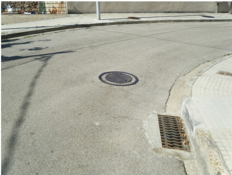
FOTO Nº2: Carrer pavimentat amb mescla bituminosa i rigola de formigó a banda i banda del vial.
