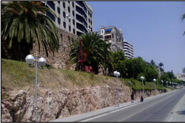
Emplazamiento sondeo S-5
