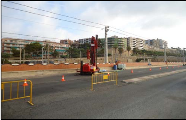
Emplazamiento sondeo S-3
