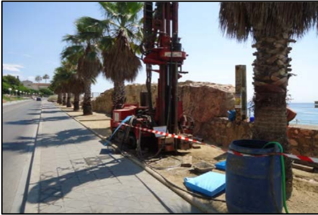
Emplazamiento sondeo S-4
