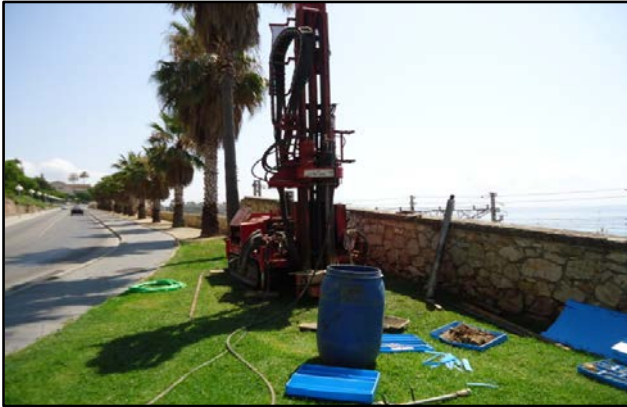
Emplazamiento sondeo S-6
