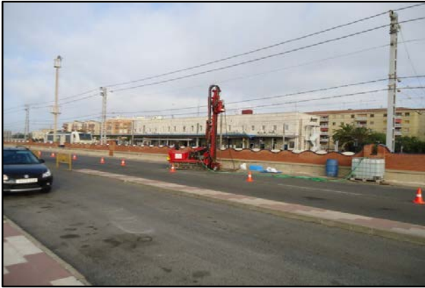
Emplazamiento sondeo S-1
