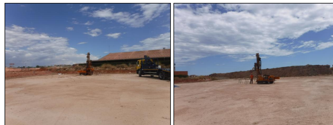
Vista general de l'obra (Juny de 2016).
