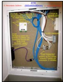
Fotografia exemple no contractual de interior registre RTRT 500x600x80mm
