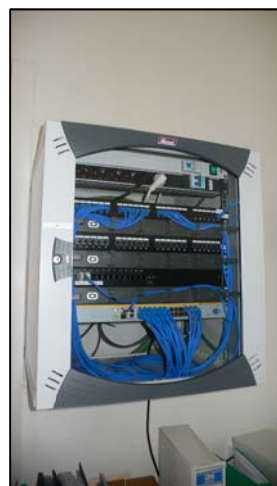
Foto exemple RACK informàtic secundari FD, instal·lació manual 18U
