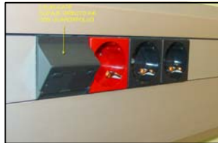
Foto exemple mecanismes 2D clipatje directe a la canal CABLOMAX amb ventanilla guardapols
