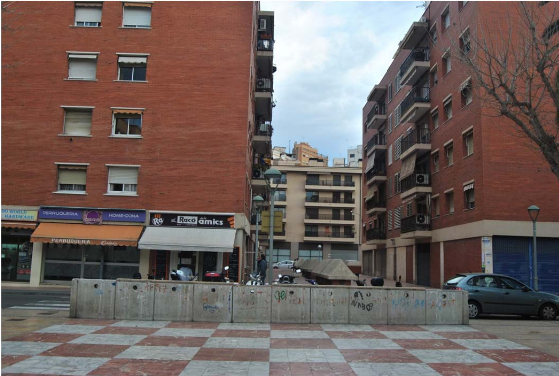
Vista de la barana de formigó a reparar
