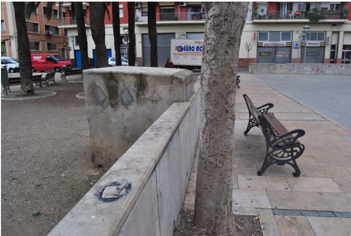
Vista de la caseta de la font a rehabilitar
