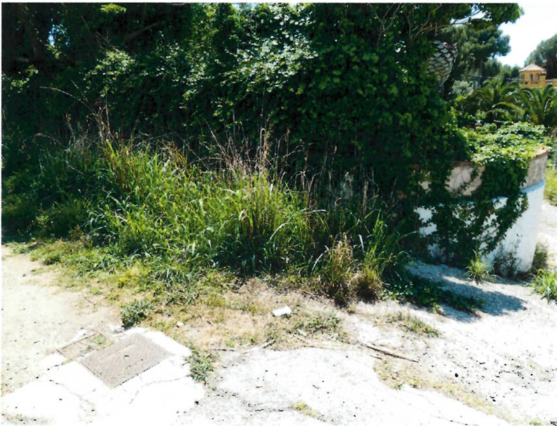
Projecte de pavimentació i serveis de vorera a la Via Augusta al tram situat entre el carrer Josep Ras i Claravalls i el carrer Manuel Albiac Tutusaus Ajuntament de Tarragona
