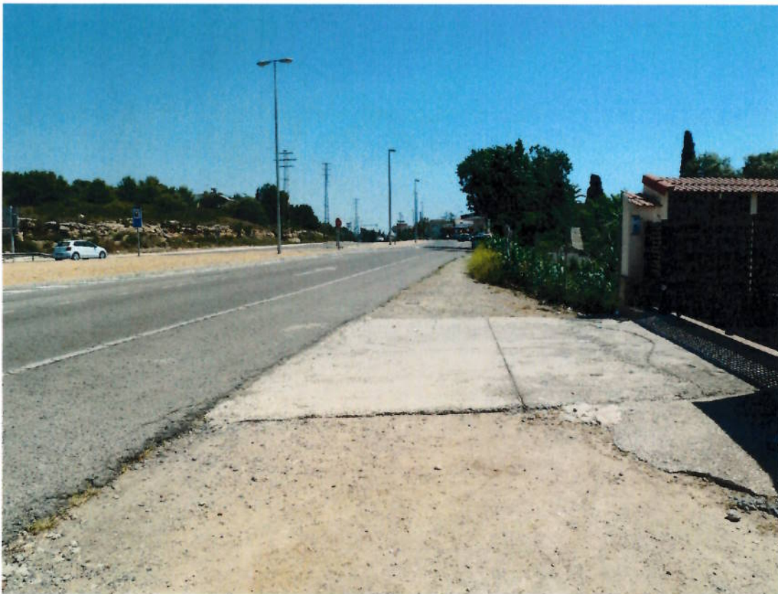
Projecte de pavimentació i serveis de vorera a la Via Augusta al tram situat entre el carrer Josep Ras i Claravalls i el carrer Manuel Albiac Tutusaus Ajuntament de Tarragona
