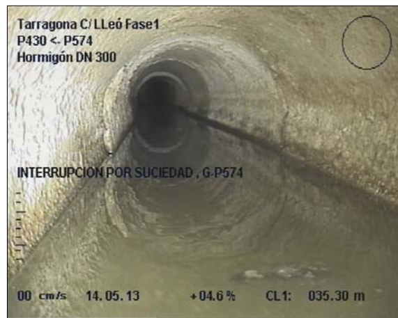
Foto: 6_21A, MPEG #: 140513_1, 00:10:44 35,3m, INTERRUPCION POR SUCIEDAD , G-P574
