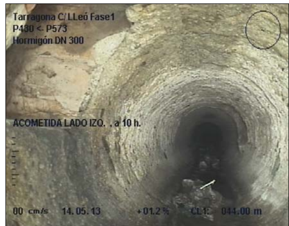
Foto: 2_10A, MPEG #: 140513_1, 00:04:20 44m, ACOMETIDA LADO IZQ. , a 10 h.
