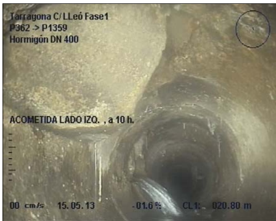
Foto: 21_8A, MPEG #: 140513_1, 00:02:38 20,8m, ACOMETIDA LADO IZQ. , a 10 h.
