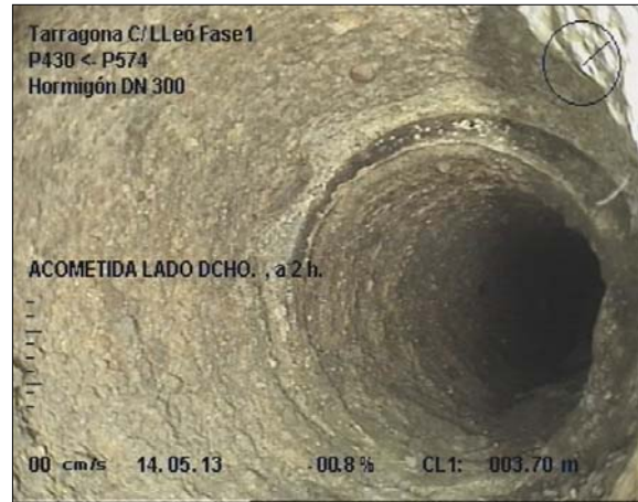
Foto: 6_4A, MPEG #: 140513_1, 00:01:17 3,7m, ACOMETIDA LADO DCHO. , a 2 h.
