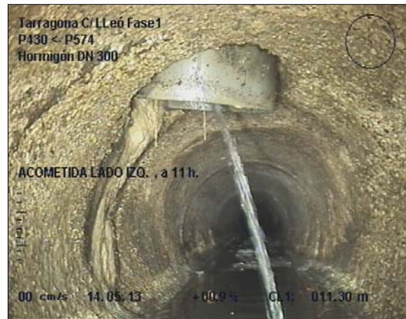
Foto: 6_11A, MPEG #: 140513_1, 00:04:51 11,3m, ACOMETIDA LADO IZQ. , a 11 h.
