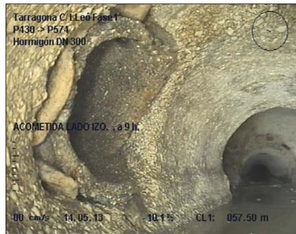
Foto: 1_15A, MPEG #: 140513_1, 00:07:34 57,5m, ACOMETIDA LADO IZO. , a 9 h.
