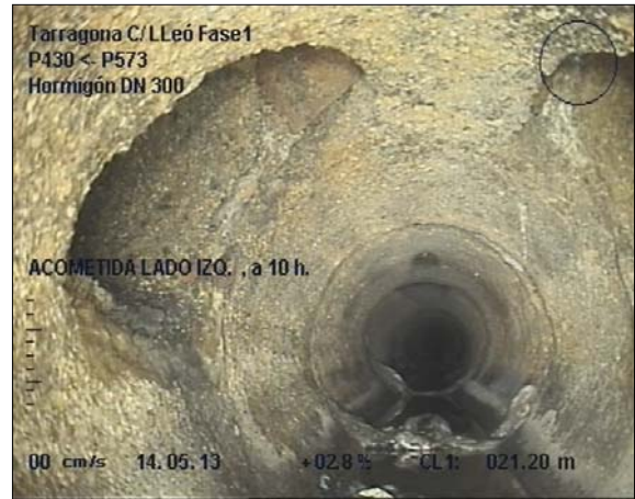
Foto: 2_4A, MPEG #: 140513_1, 00:01:19 21,2m, ACOMETIDA LADO IZQ. , a 10 h.
