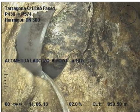
Foto: 1_18A, MPEG #: 140513_1, 00:08:41 58,5m, ACOMETIDA LADO IZQ. A POZO , a 10 h.
