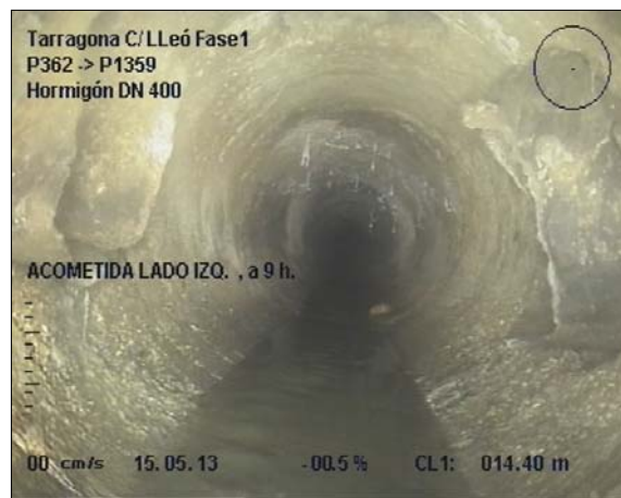
Foto: 21_6A, MPEG #: 140513_1, 00:01:50 14,4m, ACOMETIDA LADO IZQ. , a 9 h.
