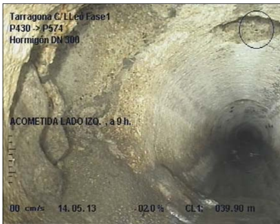
Foto: 1_8A, MPEG #: 140513_1, 00:03:58 39,9m, ACOMETIDA LADO IZQ. , a 9 h.
