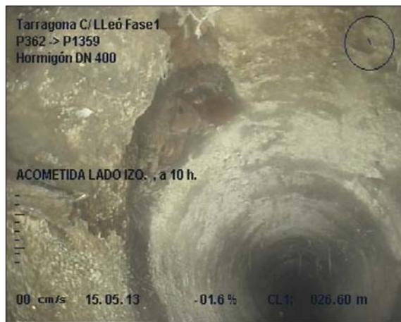
Foto: 21_11A, MPEG #: 140513_1, 00:03:46 26,6m, ACOMETIDA LADO IZQ. , a 10 h.
