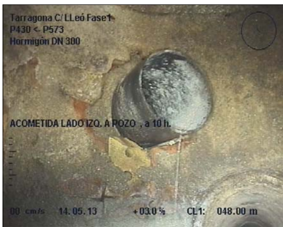
Foto: 2_13A, MPEG #: 140513_1, 00:05:20 48m, ACOMETIDA LADO IZQ. A POZO , a 10 h.
