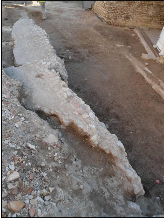
15, 16. Detalle del muro caído UE 2. A la izquierda puede verse cómo se ha fracturado por la mitad. A la derecha el agujero –UE 33- dejado en la caída donde encaja el extremo del muro.
