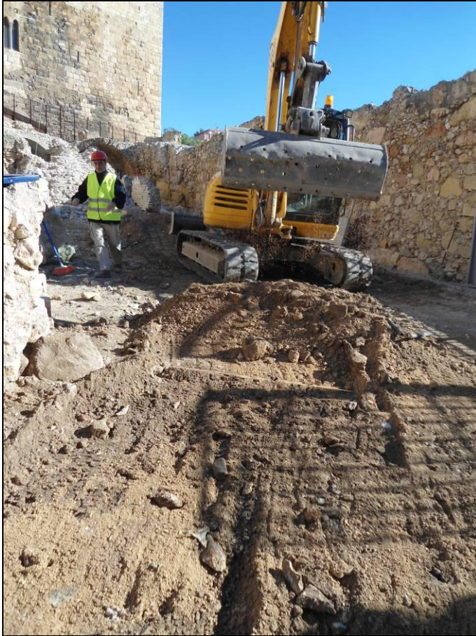
13. Detalle del rebaje del pavimento de gravas-zahorras y hormigón en el sector B.
