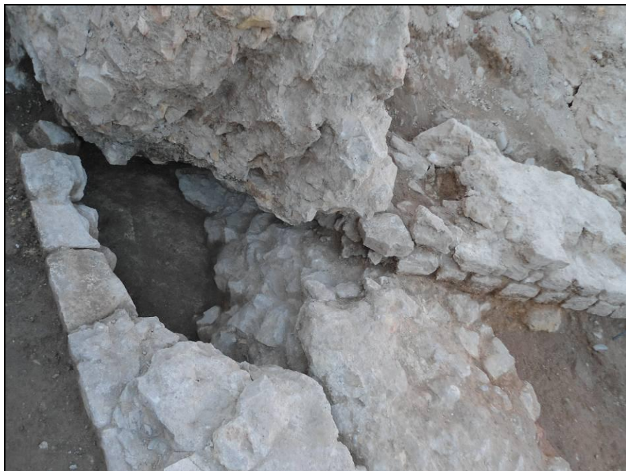
32. Detalle del ángulo del muro lateral de la bóveda –UE 19- y su cimentación –UE 32-, que como puede verse marca un giro perpendicular para dibujar el contrafuerte o riostra –UE 35-.
