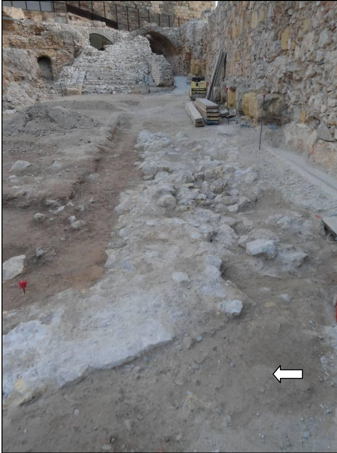
25. Detalle del ángulo NE de la porta triumphalis, en el extremo del muro de cierre lateral UE 25, junto al que aparece la solera de hormigón romano UE 29 (en blanco).
