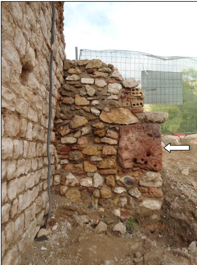
8. Detalle del alzado oriental del muro UE 4, con la puerta (en blanco). A la izquierda el muro sur de la porta triumphalis realizado en opus vittatum .
