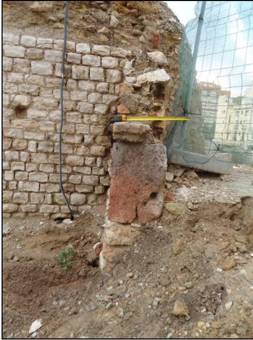
12, 13. Detalle de la sección de los muros UE 4 i 5. A la izquierda queda en alzado el lateral de la puerta abierta en el muro UE 4. A la derecha el muro UE 5 seccionado, tal y como se encontraba en el momento de iniciar nuestra intervención.
