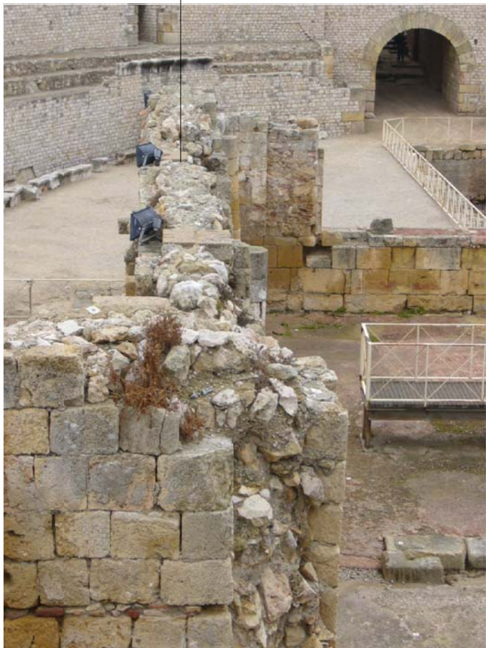
DETALL AMB EVIDÈNCIES DE DETERIORAMENT AL CORONAMENT DEL MUR DE LA BASÍLICA
