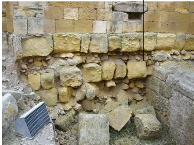
PRESENCIA DE EVIDENT DE DESGAST A LA FONAMENTACIÓ DE L'ALA NORD BASÍLICA
