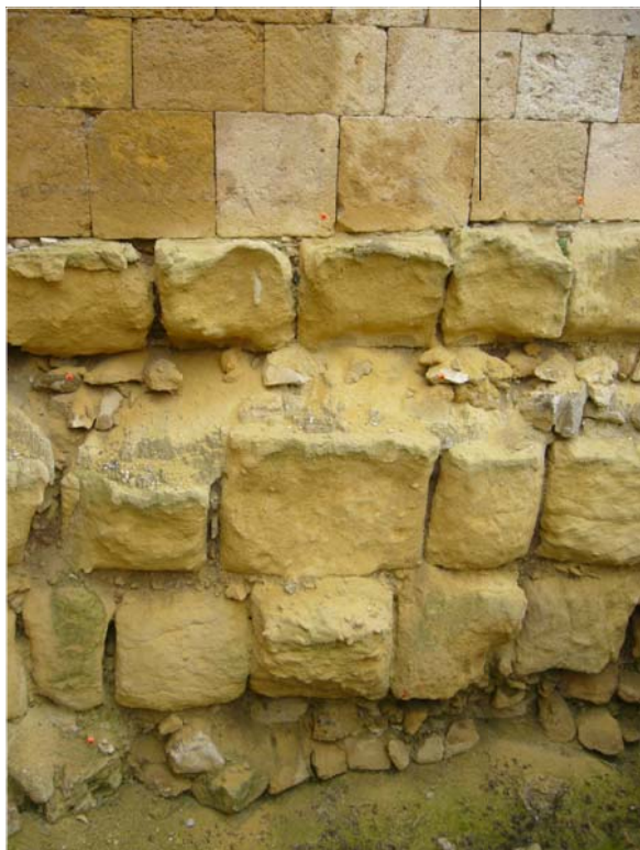
DETALL DESGAST EN EL BASAMENT DE LA FONAMENTACIÓ
