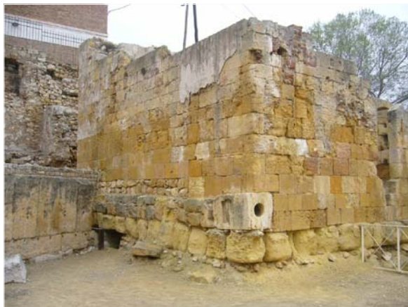
DESGAST DELS CARREUS DE LA FONAMENTACIÓ A L'ALA NORD DE LA BASÍLICA
