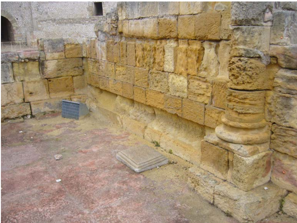
Cara interior sector Sud-Oest de la basílica, on s'observa el desgast de la pedra.
