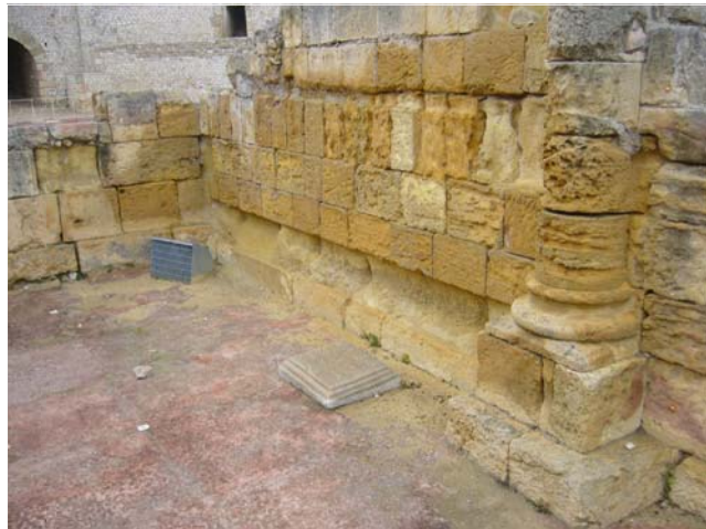
DETALL DEL DESGAST DE CARREUS CARA INTERIOR FAÇANA NORD-OEST DE LA BASÍLICA
