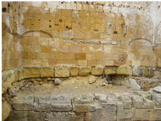
DETALL FONAMENTS DE L'INTERIOR A L'ALA NORD-OEST DE LA BASÍLICA A L'ALÇADA DEL CREUER
