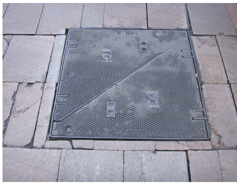
Una de las arquetas de ALPI en la zona.
