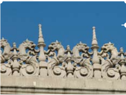
Barana Cambra de Comerç / Barandilla Cámara de Comercio
