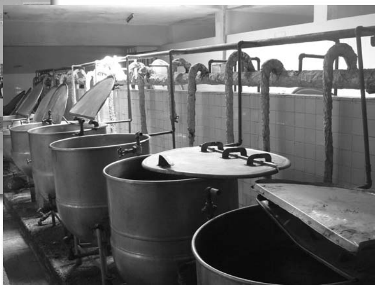
Projecte 2032. Arranjament de la cuina escolar de Ciclo I Marianao, 1a fase (Cuba). Ensenyament Solidari de Sant Boi de Llobregat
