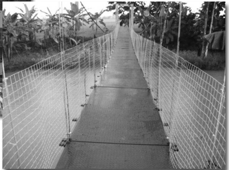
Projecte 2148. Construcció d'un pont penjant per a vianants a El Caimito (Ecuador). Asociación Runa Pacha
